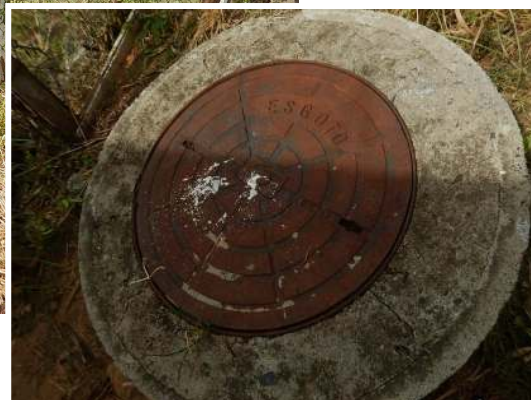
VISTA DA SERVIDÃO NO TRECHO DE ACESSO AO IMÓVEL, PODENDO-SE NOTAR O PV (POÇO DE VISITA) DA REDE DE ESGOTO INSTALADA NO LOCAL.
