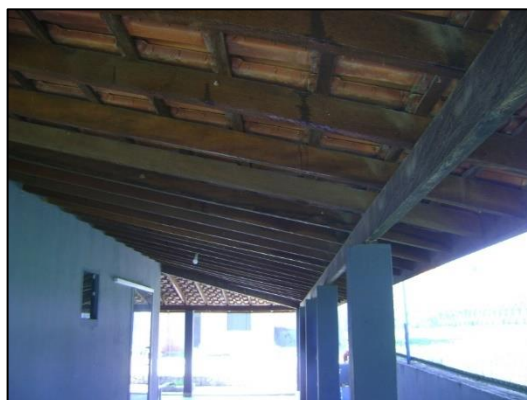
Foto 19: Detalhe da cobertura da edificação principal
