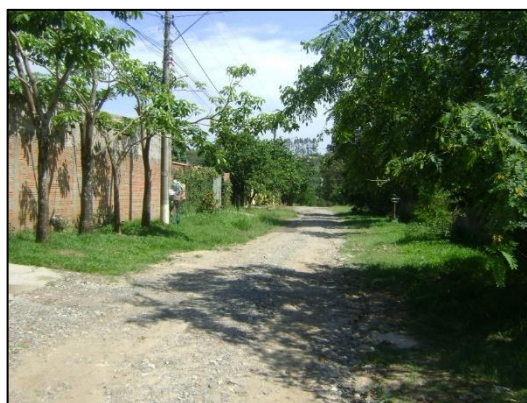
Foto 5: Rua interna do condomínio
