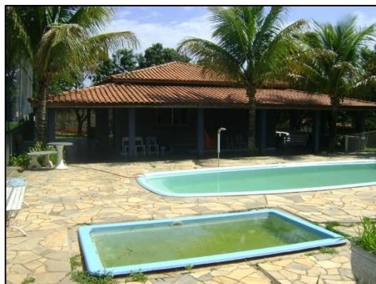
Foto 17: Edificação principal, piscina adulto e infantil
