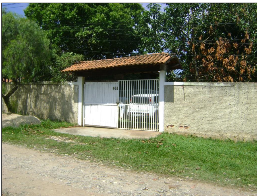
Foto 1: Fachada do imóvel
