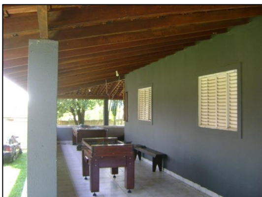
Foto 18: Varanda da edificação principal
