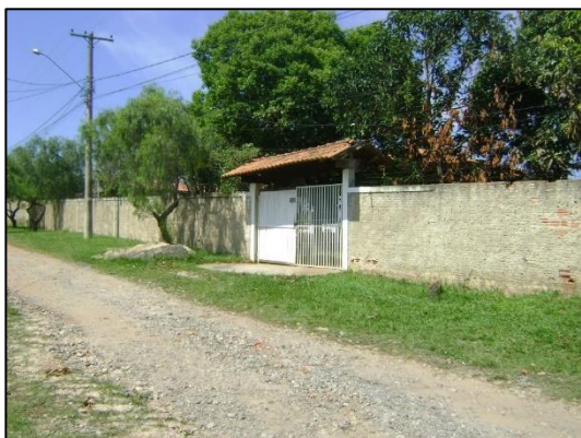
Foto 6: Fachada do imóvel
