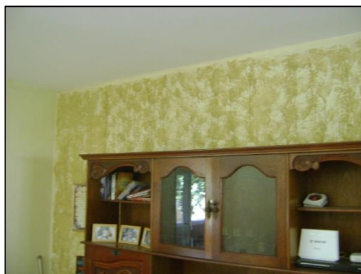
Foto 25: Detalhe do revestimento
