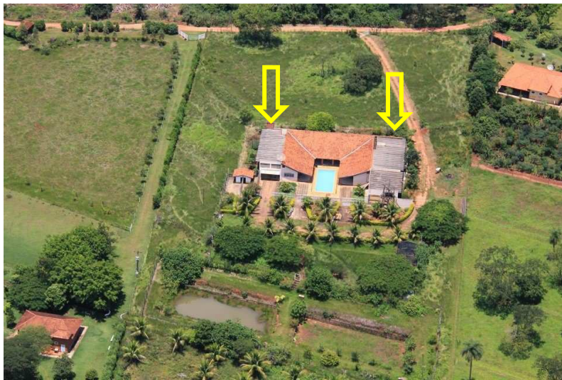
Foto 09: corpo secundário, identificado pelas setas na cor amarelo.
