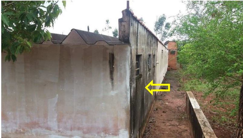
Foto 07: corpo secundário, área anexa ao corpo principal, cobertura de telhas de fibrocimento tipo canaleta.
