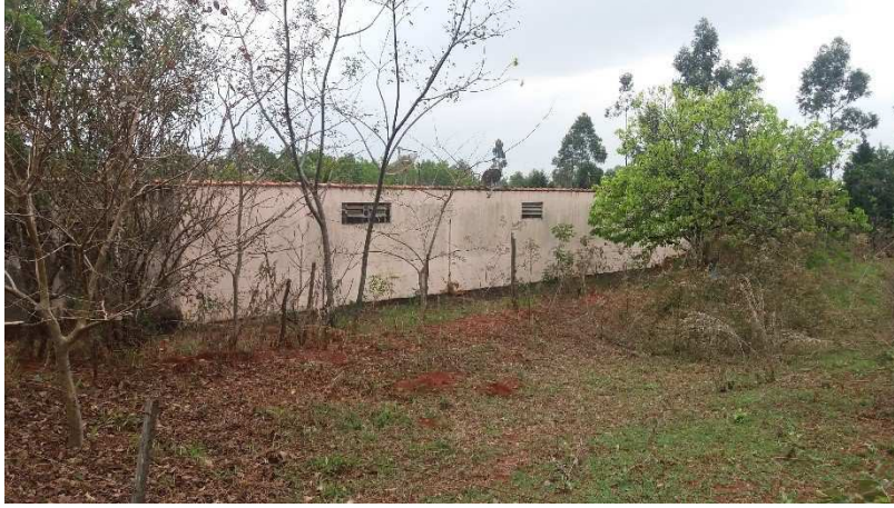
Foto 06: imóvel objeto desta lide, destacando a parte dos fundos da área de lazer.
