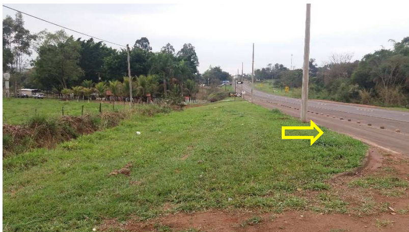
Foto 02: Trecho pavimentado, ligação da SP – 321, Rodovia Cezário José de Castilho, com a cidade de Arealva.
