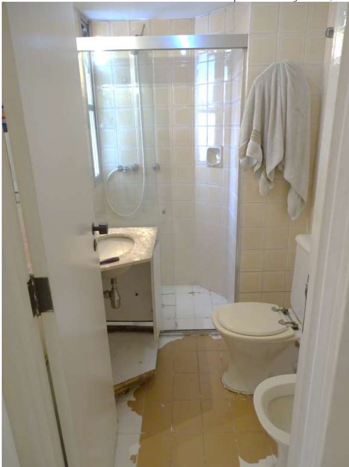
FOTO- 21 – BANHEIRO SOCIAL
