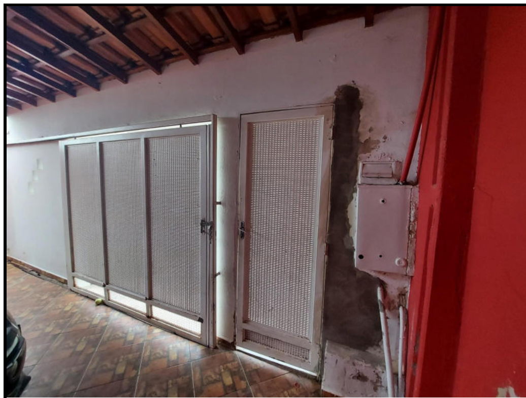
Foto 05 - Portão de entrada
