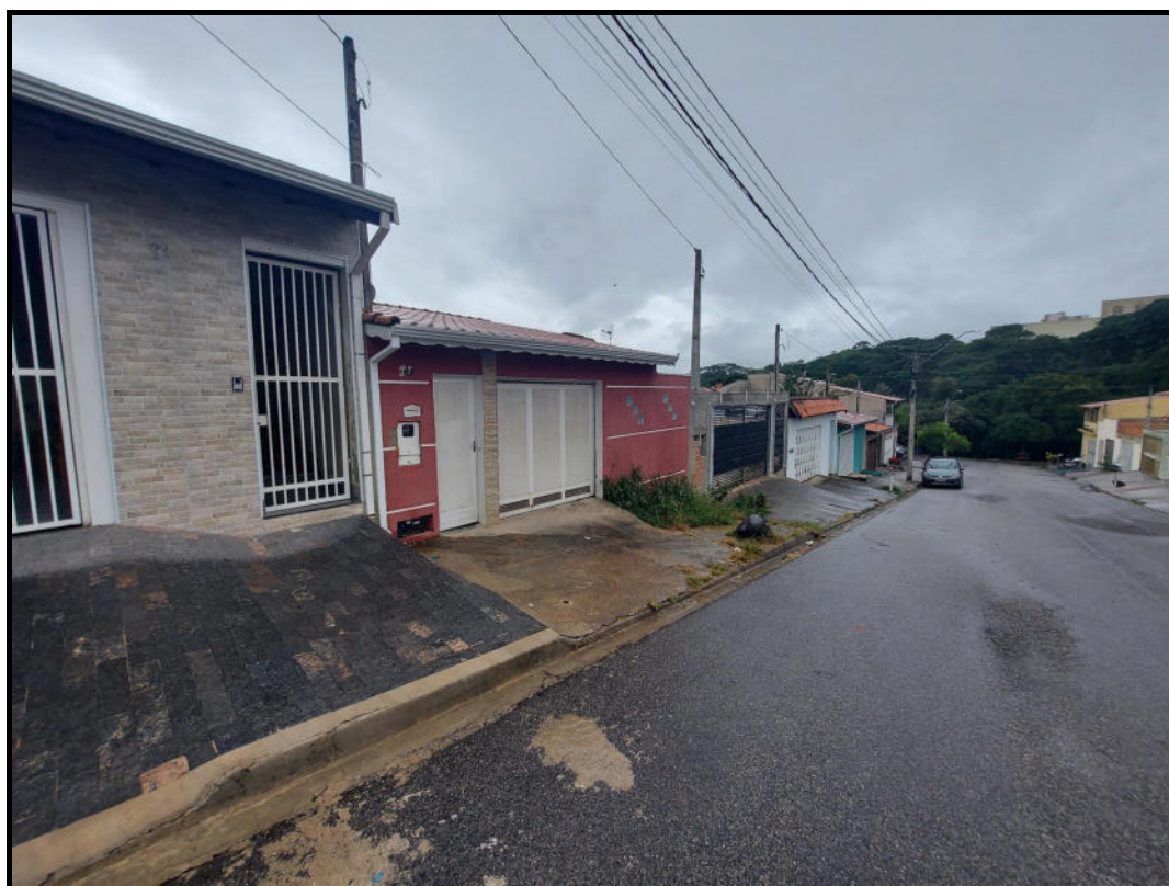
Foto 03 - Vista frontal do imóvel avaliando
