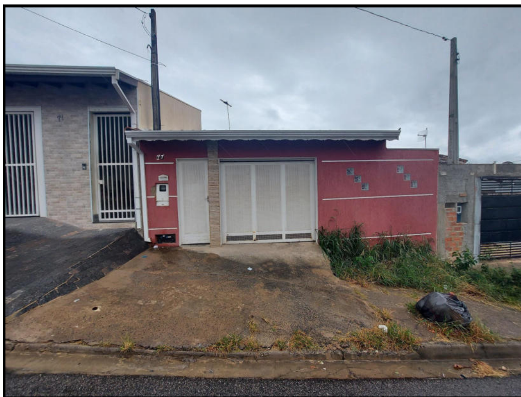
Foto 01 - Vista frontal do imóvel avaliando
