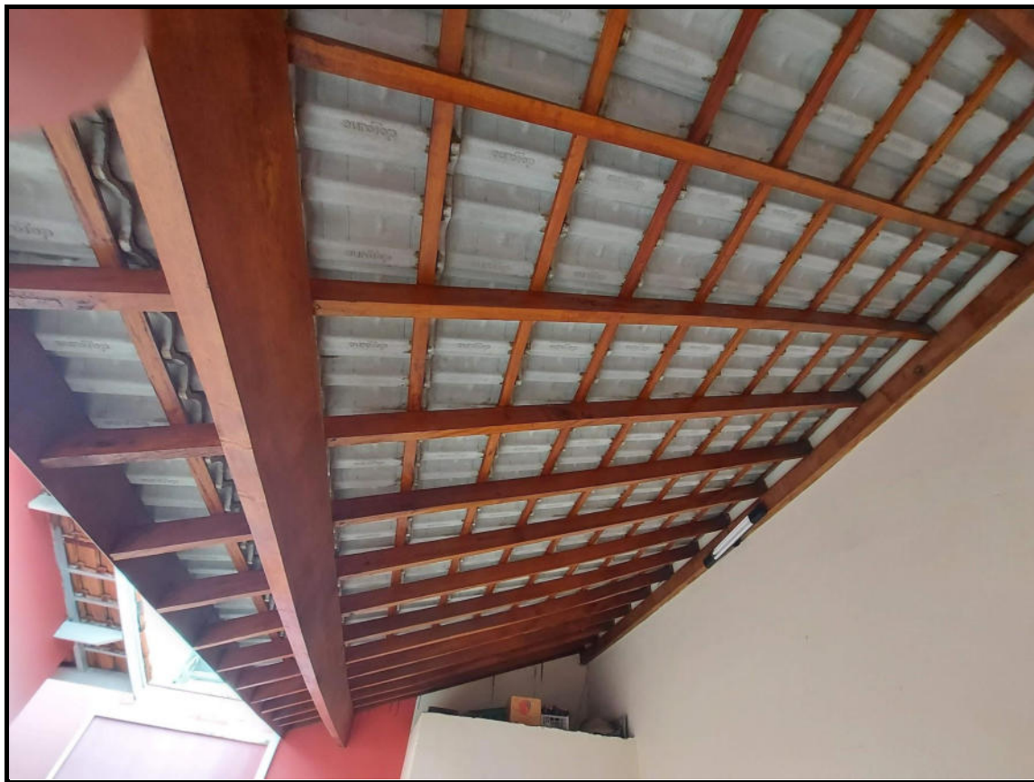
Foto 20 - Telhado - área de serviço
