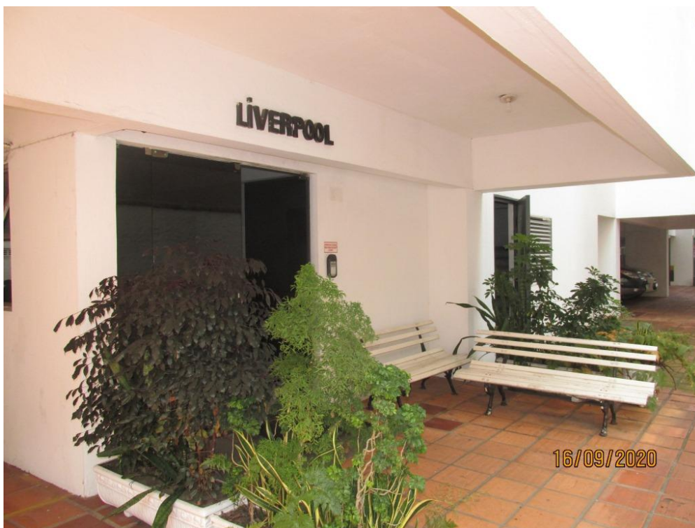
Foto 5 - Entrada do Bloco "C" – Edifício Liverpool, onde se localiza a unidade avalianda
