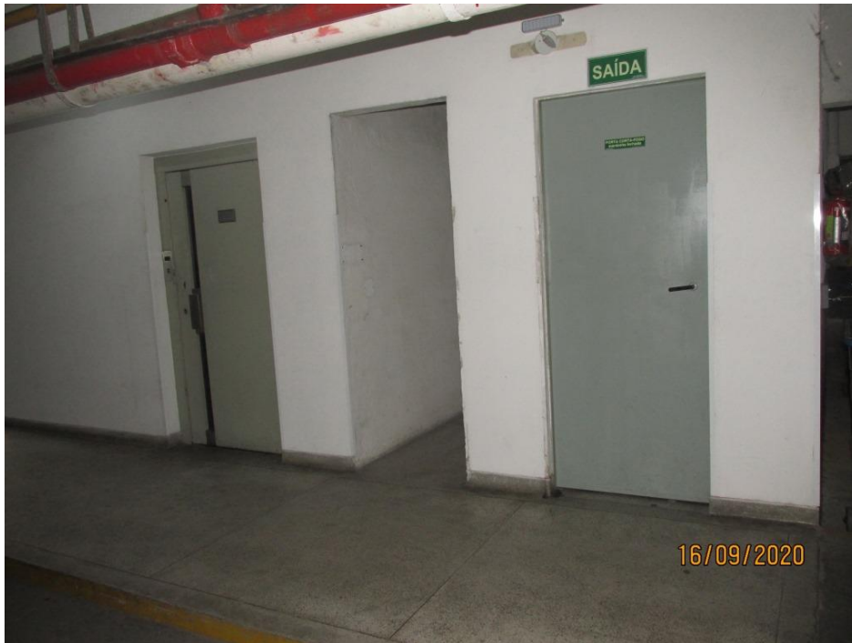
Foto 6 - Acesso a elevadores e escadaria no subsolo - garagem
