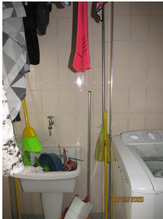
Foto 15 - Área de serviço com mesmo padrão de acabamento do banheiro
