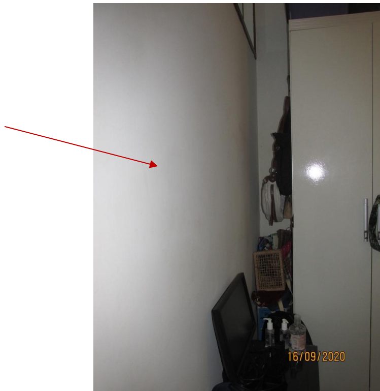
Foto 17 - Vista do mesmo quarto e parede em drywall, dividindo com outro ambiente, que é usado também como quarto
