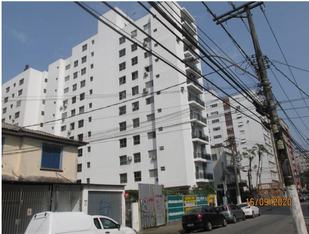
Foto 2 - Vista lateral do Bloco "A", único integrante do Conjunto Residencial, com frente direta para a via pública
