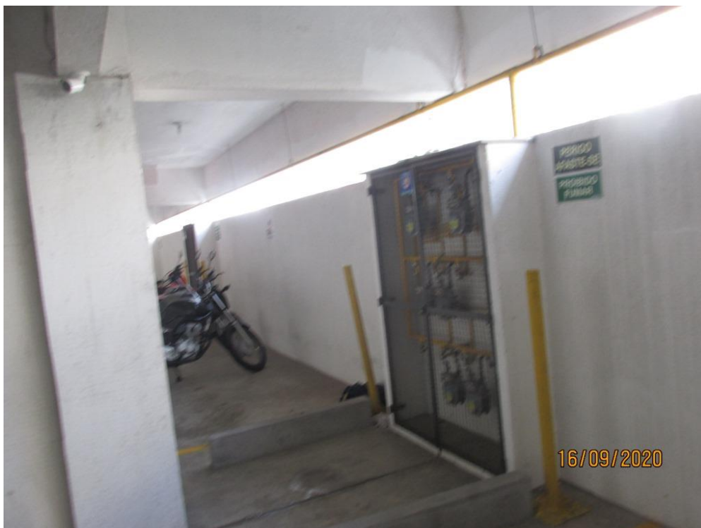
Foto 21 - Medidores de gás natural, abastecimento por tubulações oriundas da via pública
