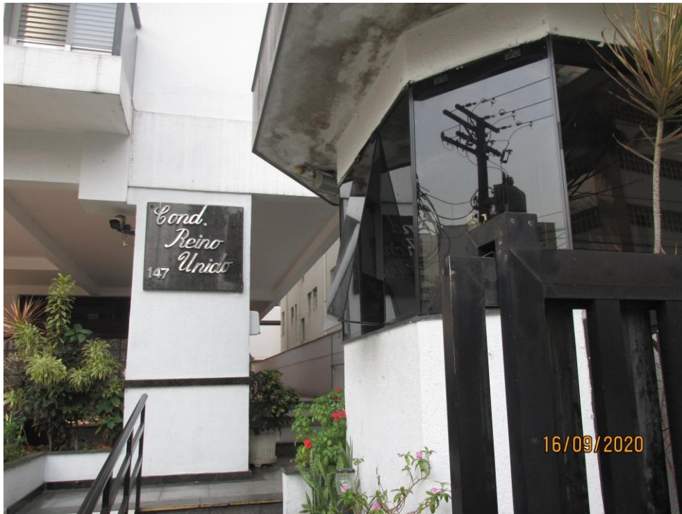
Foto 4 - Portaria geral e acesso de moradores e visitantes
