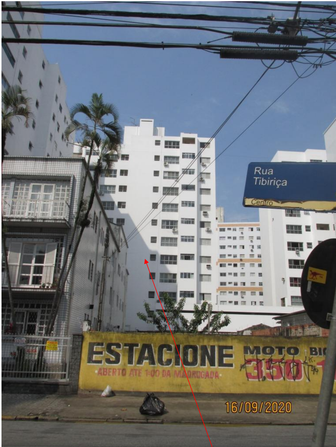
Foto 1 - Vista frontal do Bloco "C" – Edifício Liverpool, situado no fundo do terreno do Conjunto Residencial REINO UNIDO, onde se localiza a unidade avalianda
