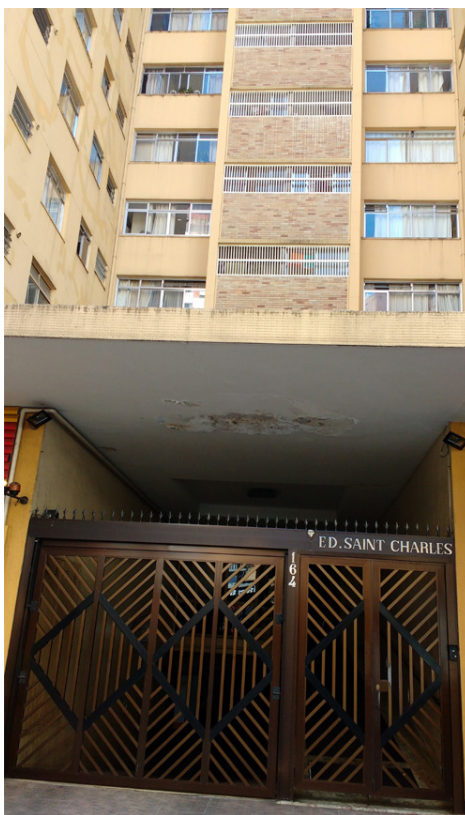
Figura 1 - Identificação do acesso ao interior do Edifício
