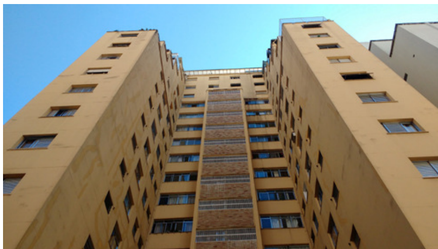
Figura 2 – Fachada do Edifício Saint Charles
