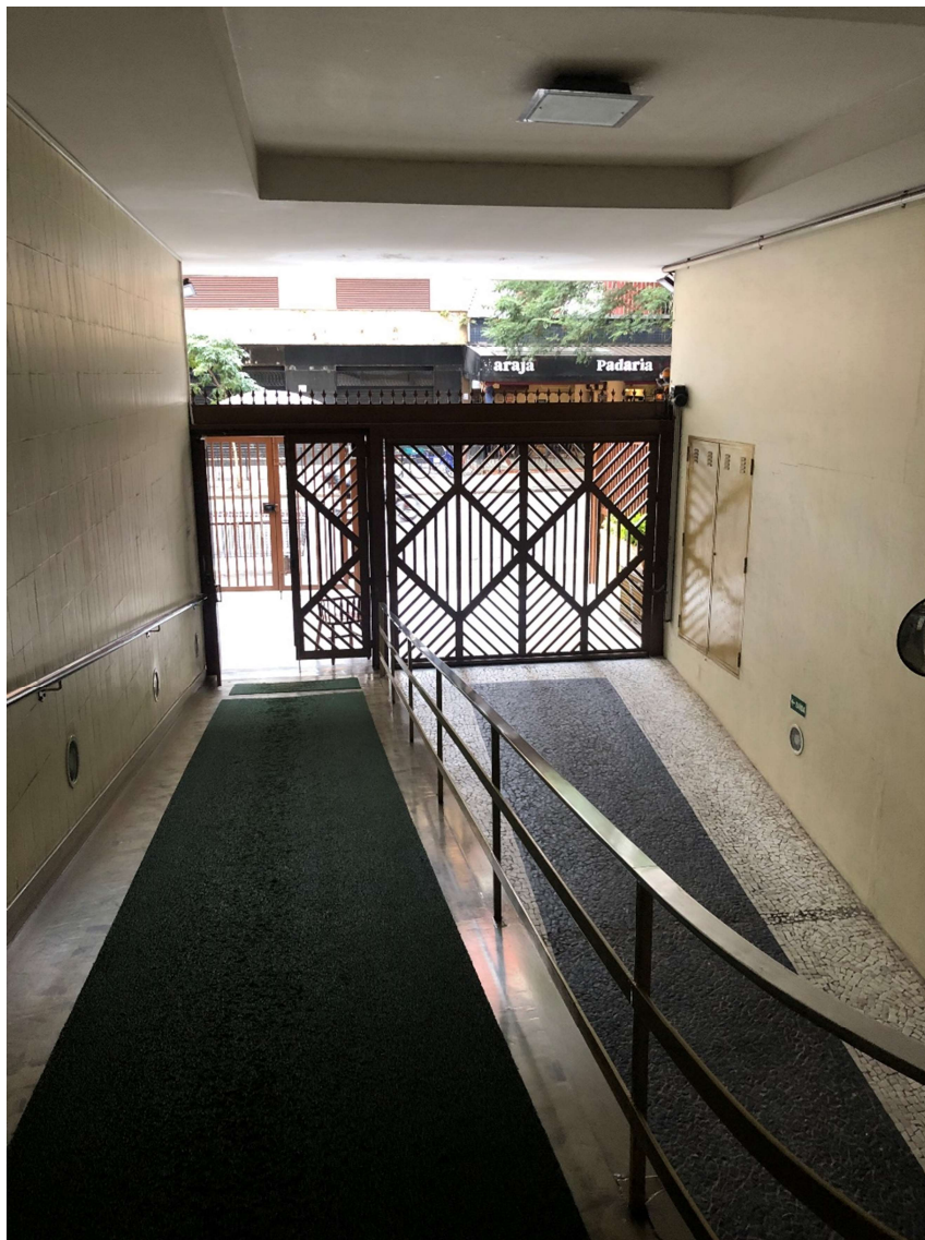
Hall de entrada de pedestres e veículos:
