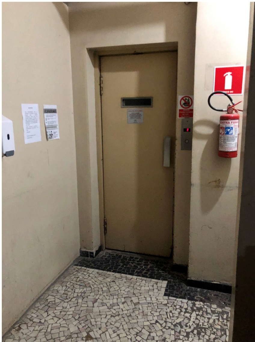
Elevador de acesso ao subsolo:
