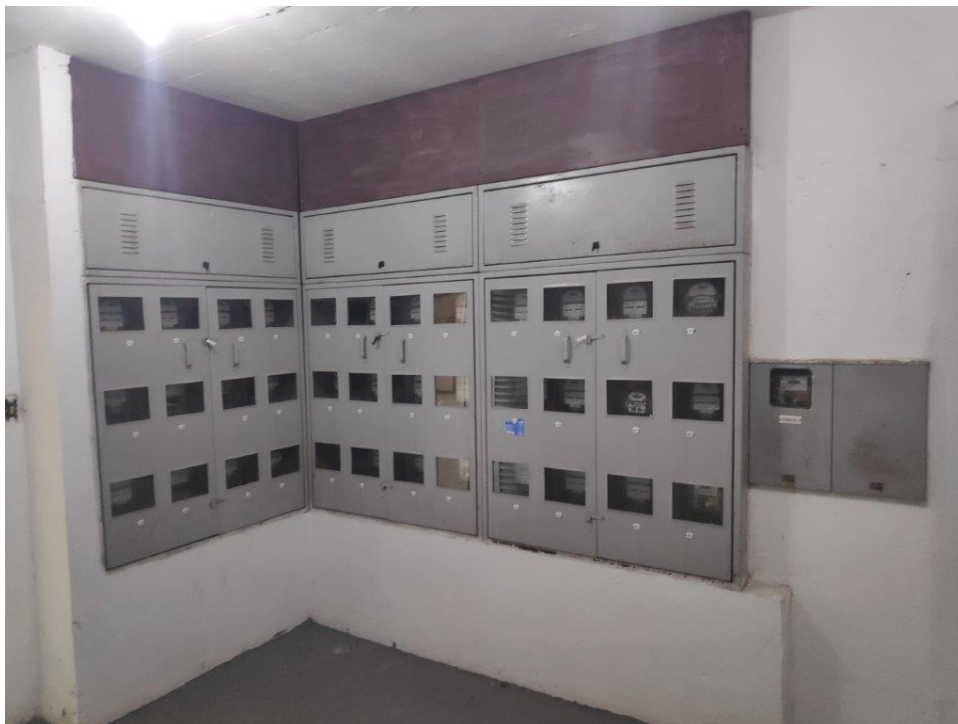
Figura 30 – Cabine de medição
