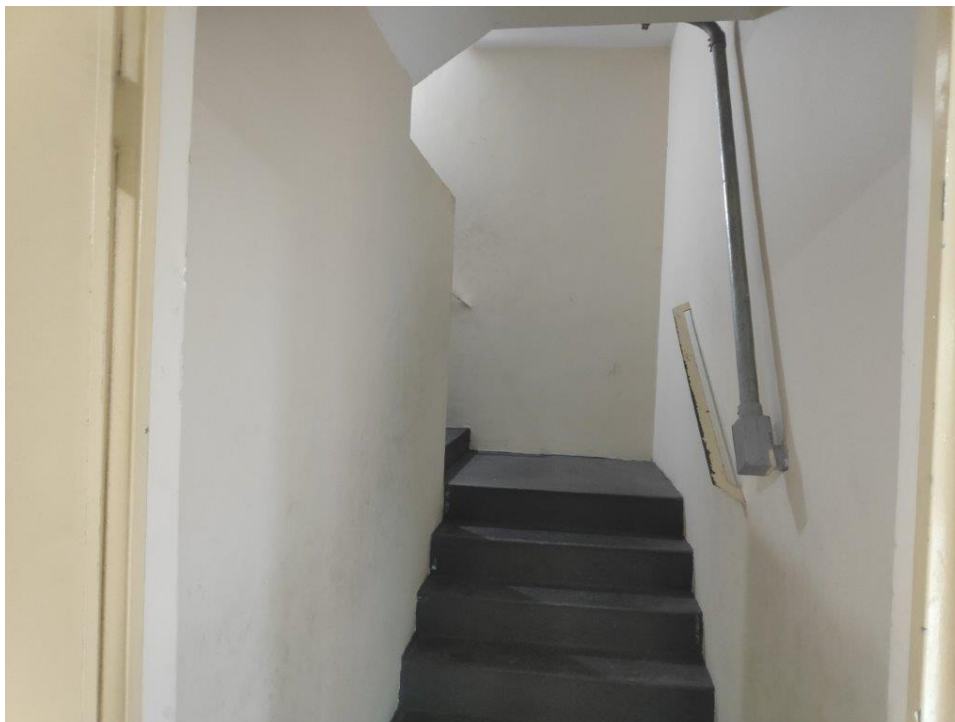
Figura 18 – Escada Torre A
