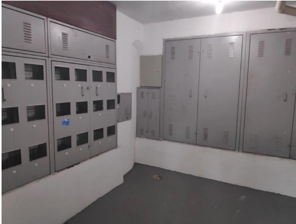
Figura 29 – Cabine de Medição
