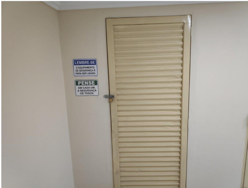
Figura 17 – Casa da máquinas
