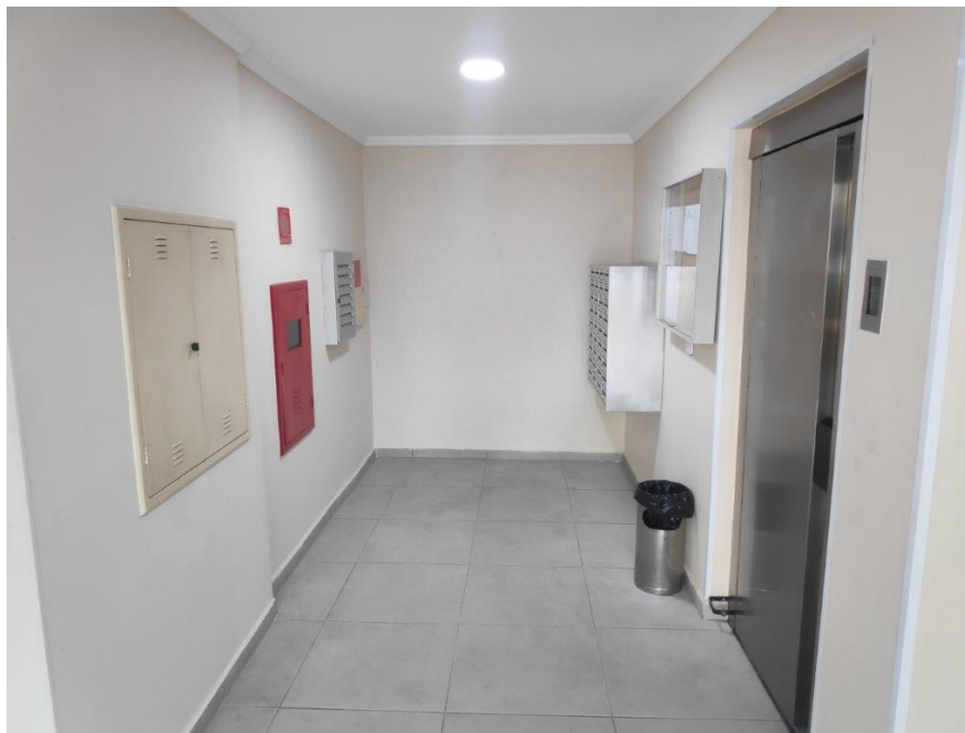
Figura 8 – Hall de Entrada do edifício
