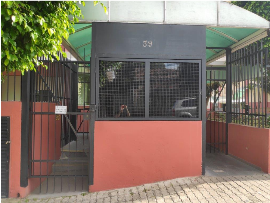
Figura 3 - Entrada do edifício
