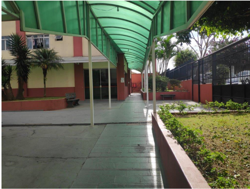
Figura 25 – Área externa de acesso entre as torres
