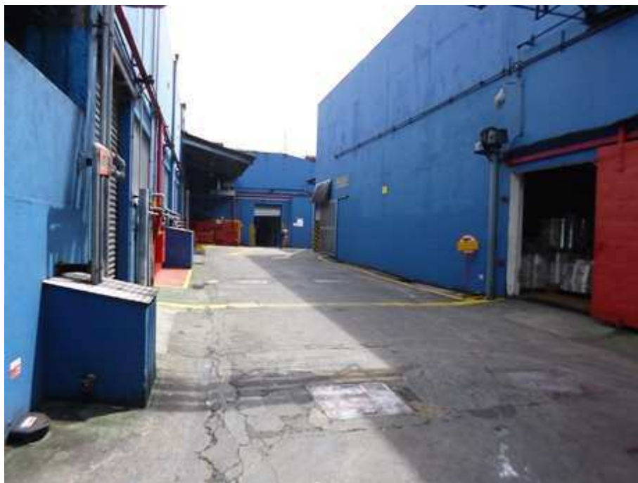
Outros aspectos parciais das fachadas dos galpões.
