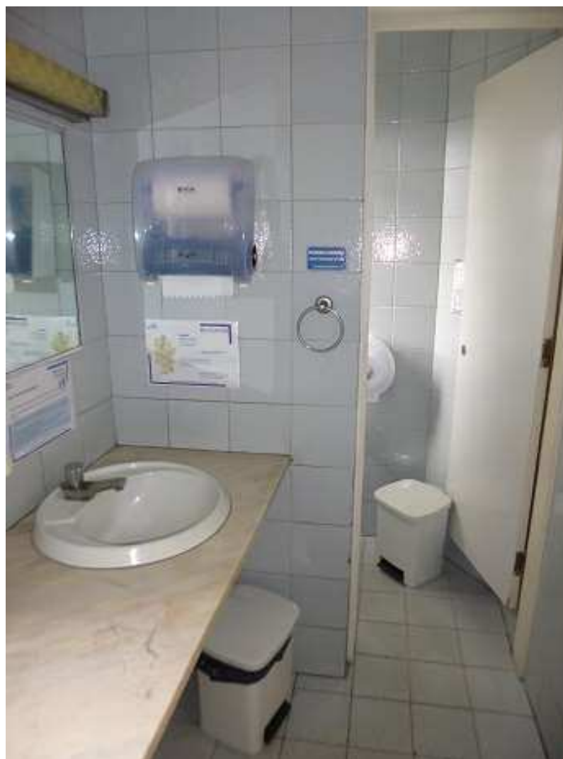
Detalhes de acabamento e conservação do interior de um banheiro.
