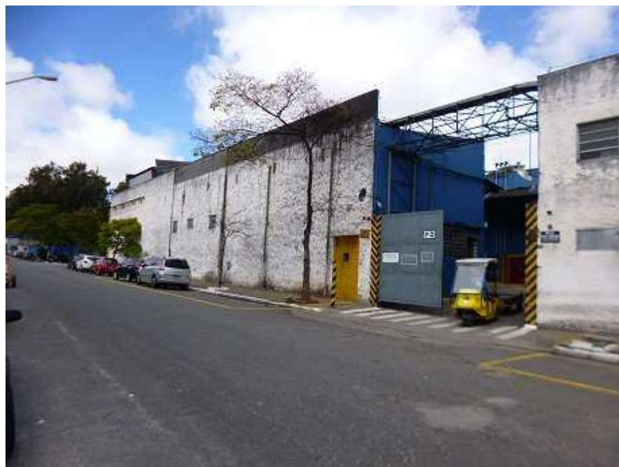
Outros aspectos da frente do imóvel para a Rua Herbert Alfred Landsberger.
