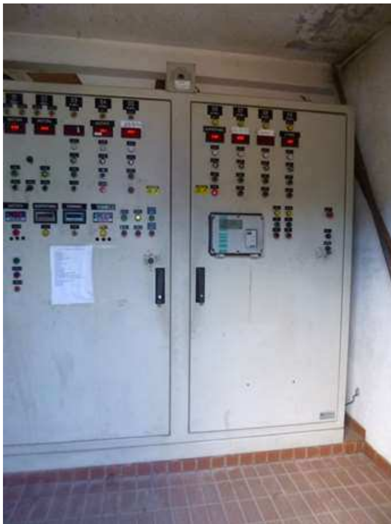
Vista parcial do painel de controle de solventes.
