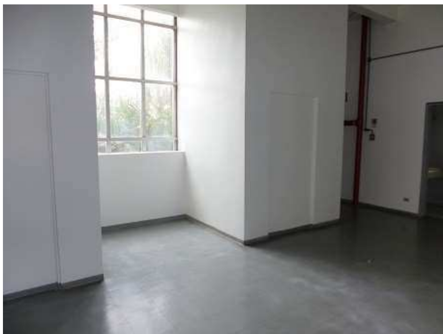
Detalhes de acabamento e conservação do hall dos elevadores.
