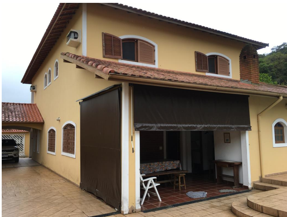
Figura 18: Vista posterior da casa.
