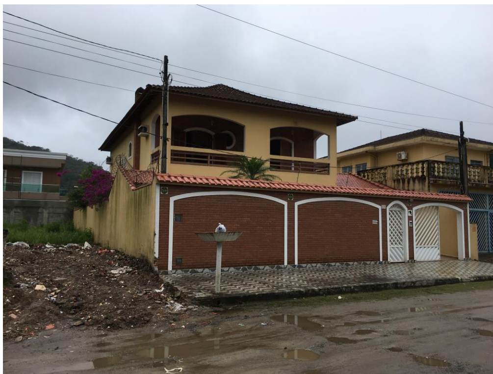
Figura 2: Vista geral do imóvel.
