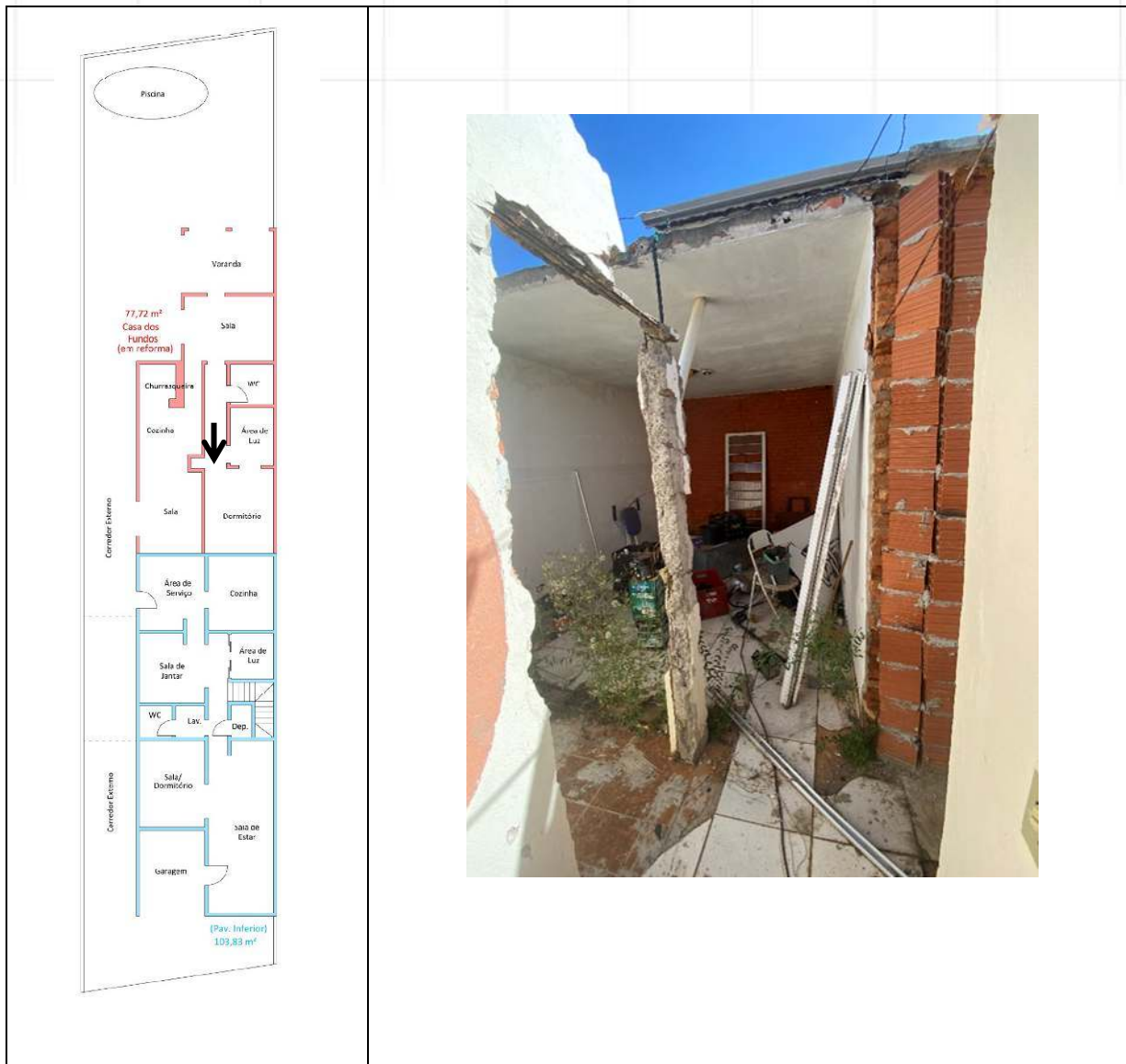
DETALHE DO HALL DO DORMITÓRIO, PODENDO-SE NOTAR O ESTÁGIO DA REFORMA PARALISADA.
