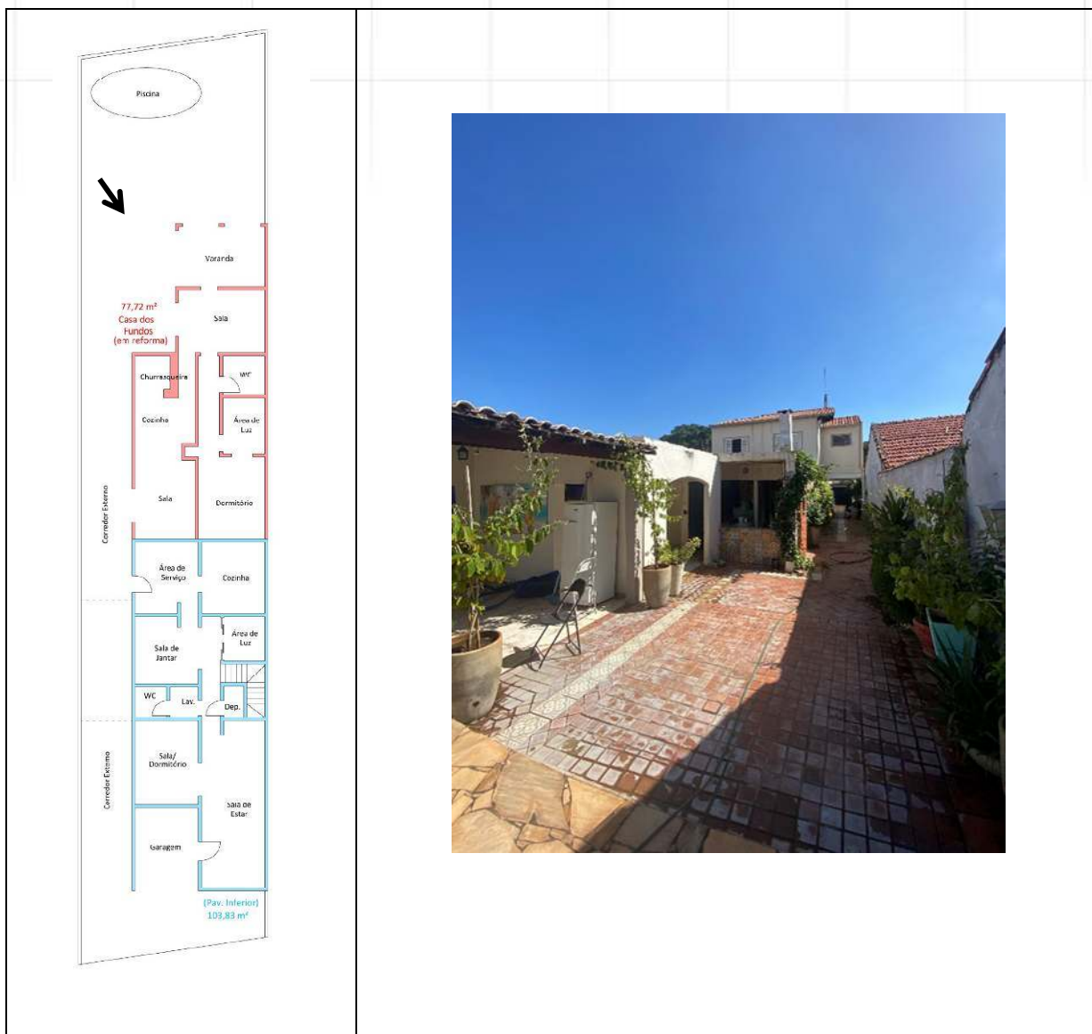
OUTRA VISTA DA CASA DOS FUNDOS.
