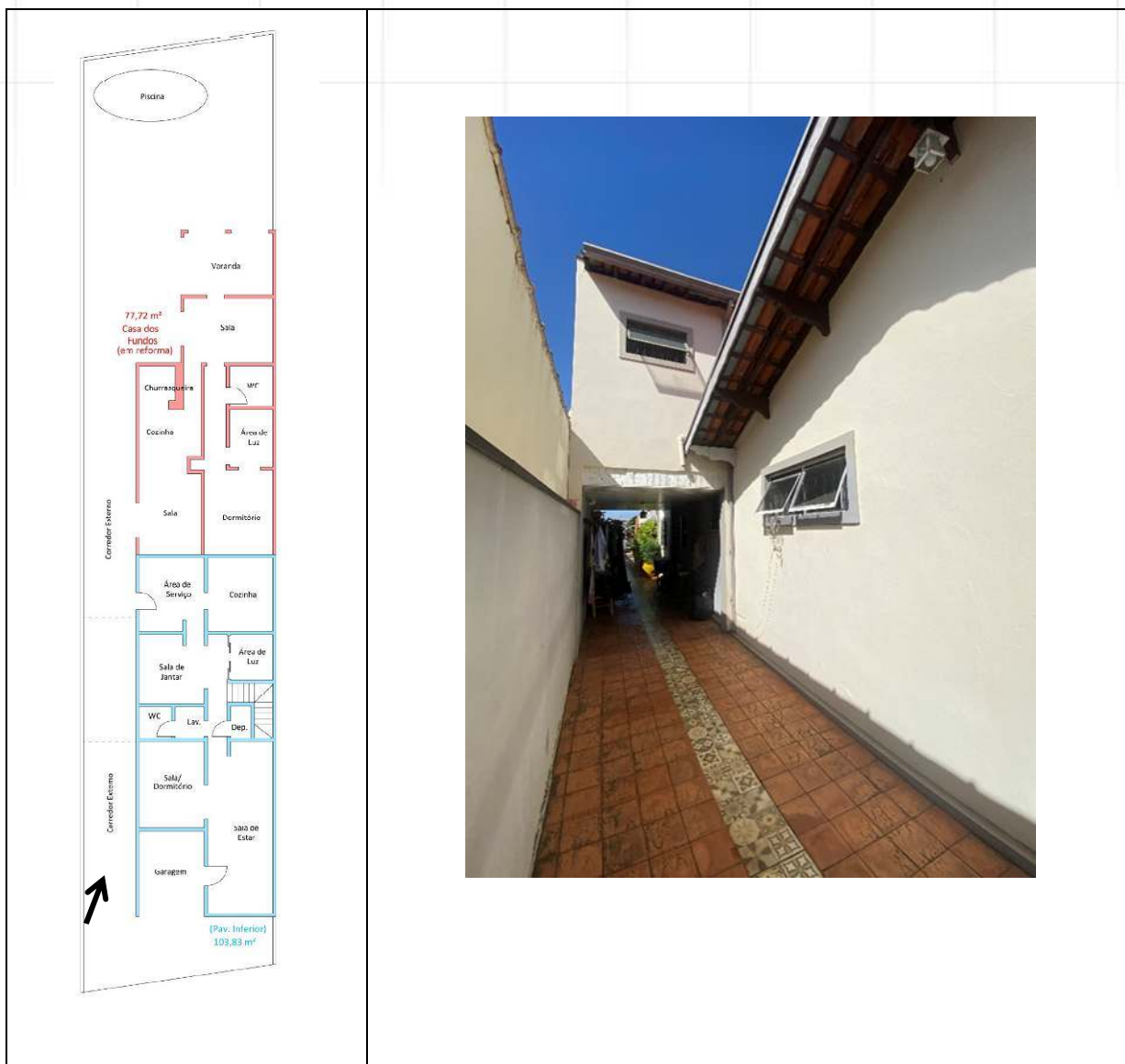
CORREDOR EXTERNO, PODENDO-SE NOTAR PARTE DO PAVIMENTO SUPERIOR DA CASA DA FRENTE.
