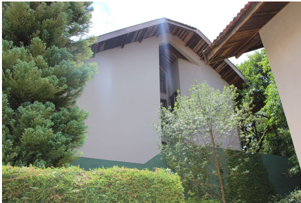
Vista Lateral Direita do imóvel
