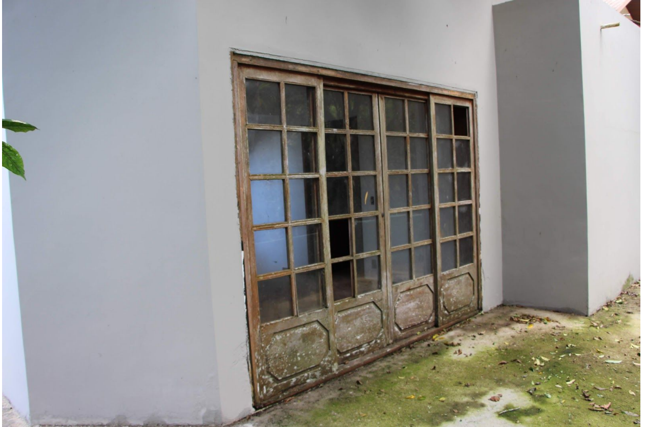
Área externa dos fundos do imóvel, acesso para sala de jantar
