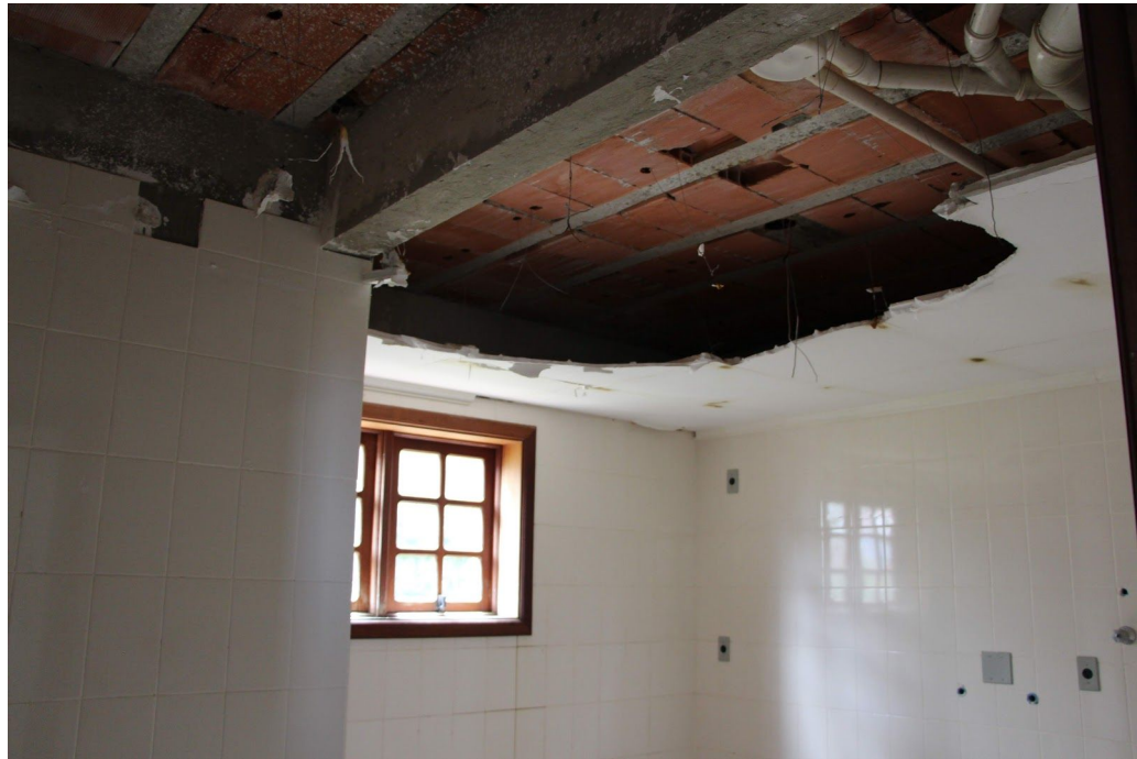
Cozinha ( teto de gesso avariado)
