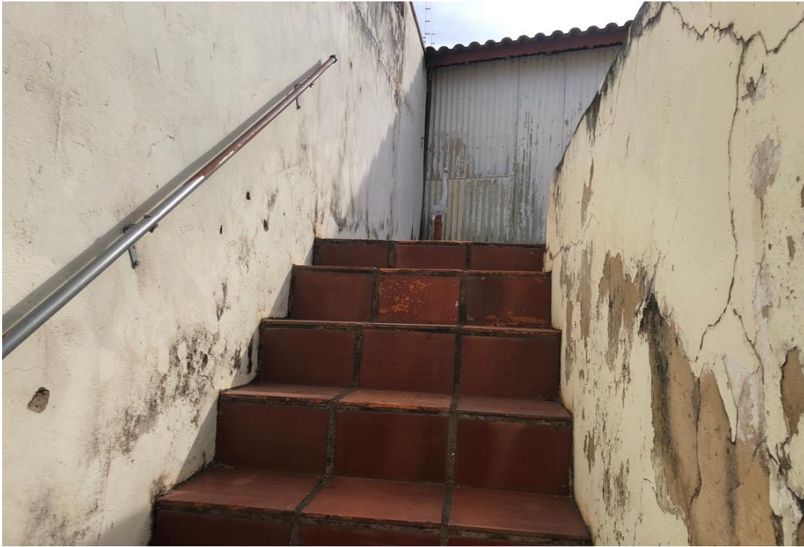
Acesso aos fundos
