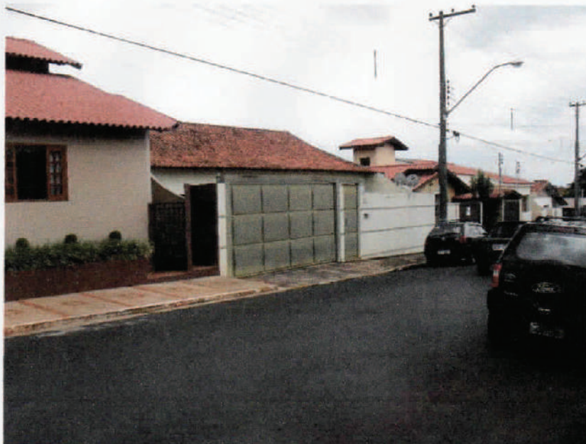
Foto 09 – Identificando o imóvel da Rua Major Mariano, 1142, matrícula 6.816.
