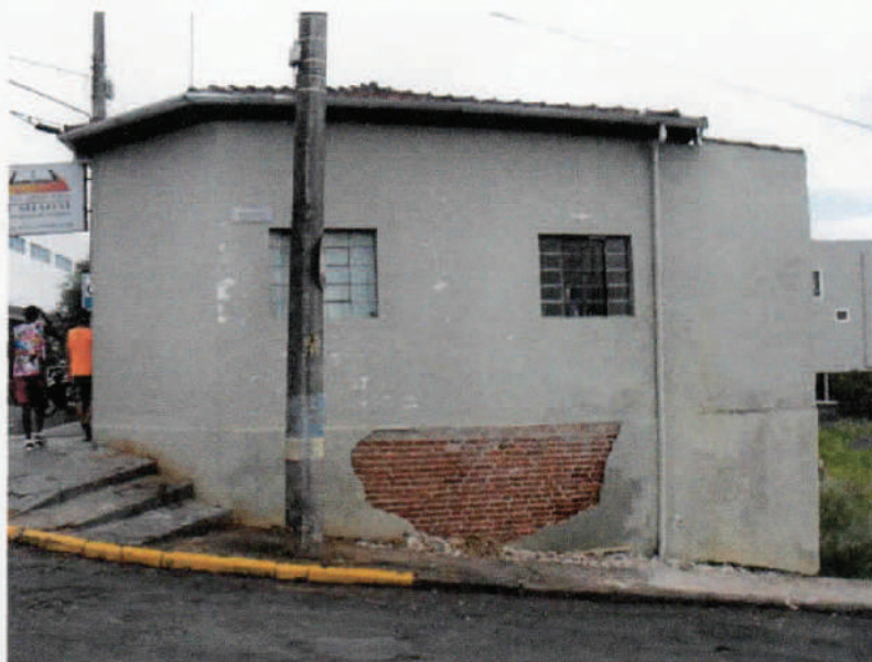
Foto 18 – Mostrando a parte da esquina com a outra via do imóvel comercial.
