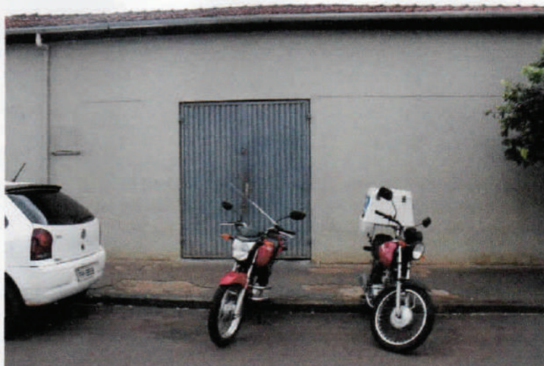
Foto 16 – Mostrando a continuação da fachada com frente para a citada avenida.
