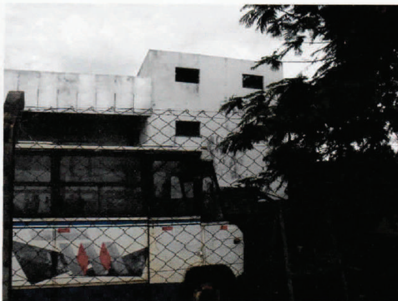
Foto 27 – Continuando a mostrar a construção do prédio avaliando.
