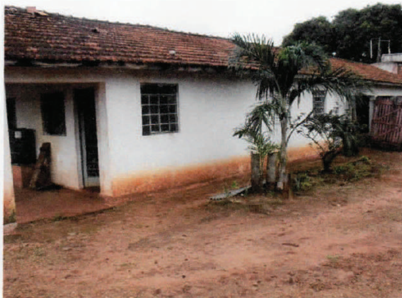
Foto 58 – Mostrando parte da casa do caseiro.
