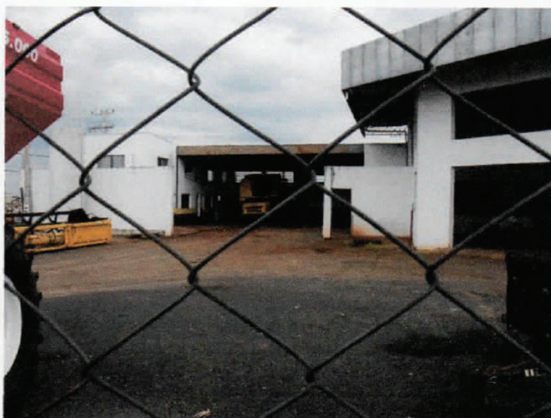
Foto 28 – Mostrando outras construções anexas ao prédio principal.
