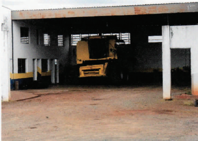
Foto 32 – Mostrando um anexo do prédio.
