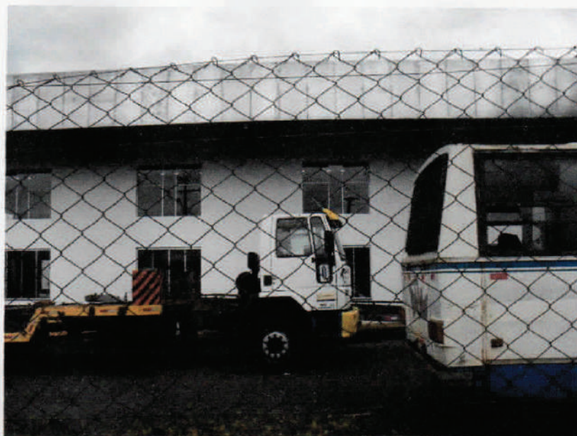
Foto 26 – Continuando a mostrar o prédio e seu nível de construção e acabamentos.
