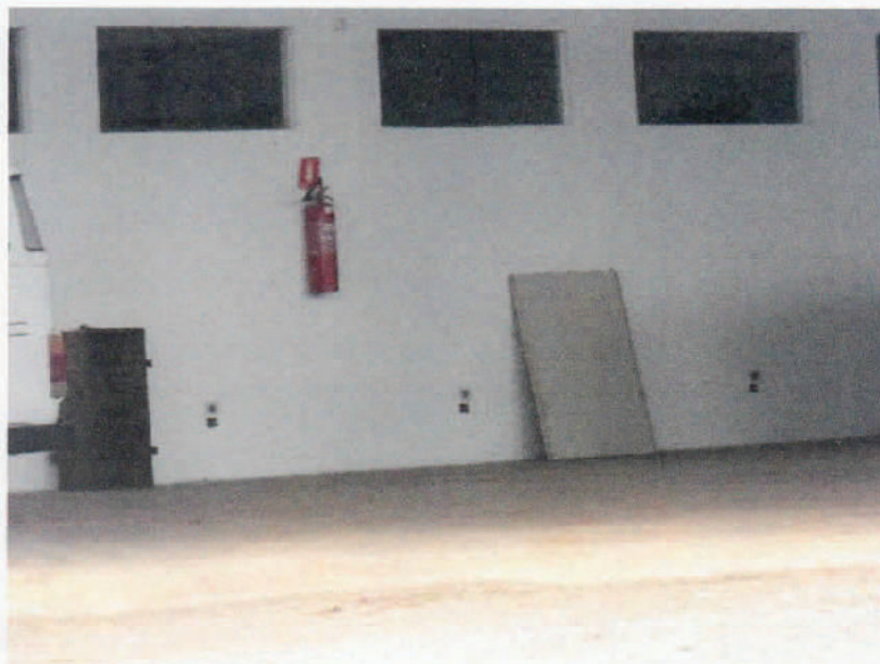
Foto 30 – Mostrando mais visualização do interior do prédio.
