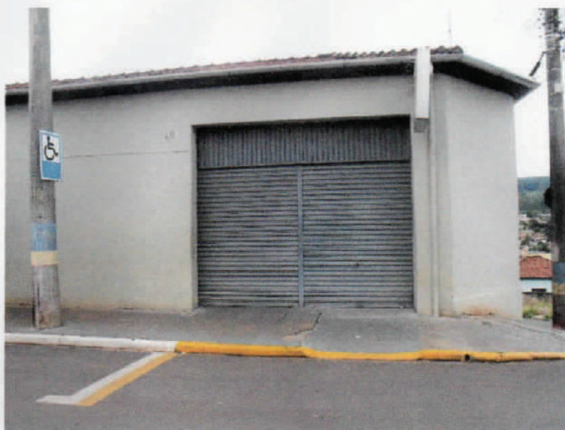
Foto 15 – Mostrando uma parte da fachada do imóvel comercial.
