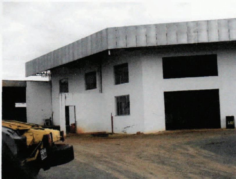
Foto 31 – Mostrando mais detalhes construtivos do prédio e seu estado de conservação.
