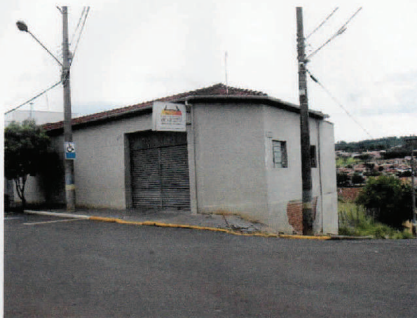
Foto 13 – Identificando o imóvel da Av. Humberto Martignoni, 662, matrícula 9.925.
