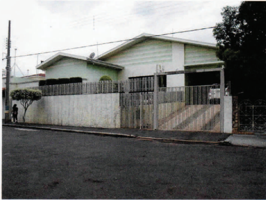
Foto 01 – Identificando o imóvel da Rua Rodrigo Vasconcellos Spinola, 233, matricula 1.714 , que fisicamente através de construção, estava unificado a mais duas matrículas de nº 2.028 e 3.034, onde se situava a casa de morada do réu. Entretanto, legalmente no CRI as referidas matrículas ainda não estava unificadas.
