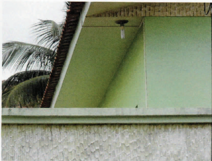
Foto 07 – Mostrando alguns detalhes da cobertura da casa.
