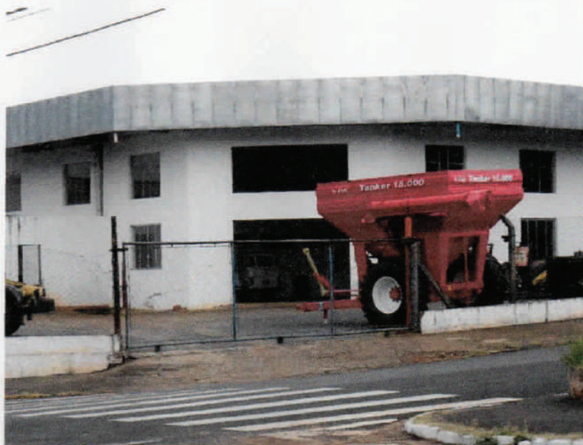
Foto 24 – Mostrando em detalhe, a fachada do prédio comercial.
