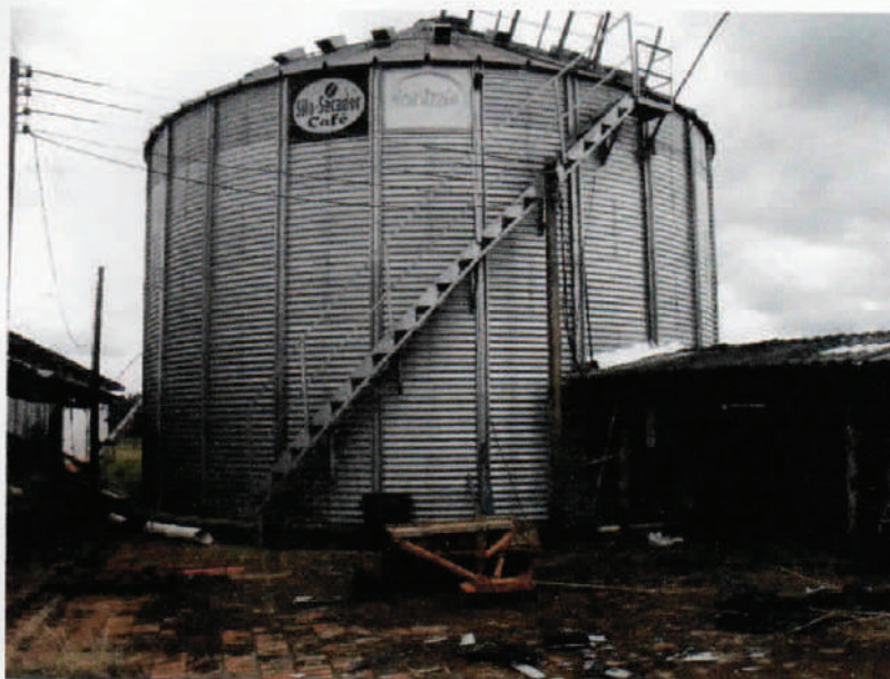
Foto 55 – Mostrando o silo de secagem de café, também já usado e seu estado de conservação.
