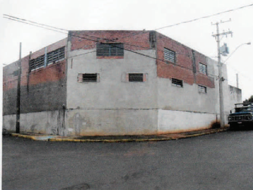
Foto 33 – Mostrando o nível da construção do prédio em sua parte dos fundos, esquina da via lateral com a dos fundos.
