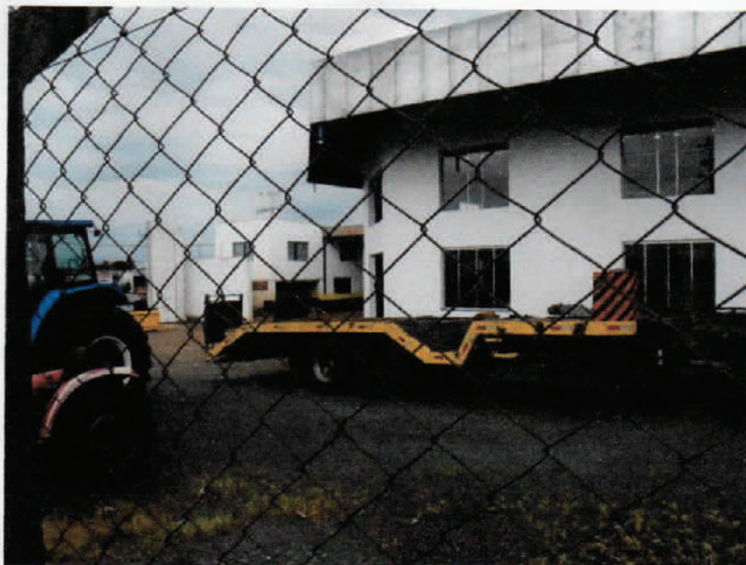
Foto 25 – Mostrando mais uma parte da fachada do prédio comercial avaliando.
