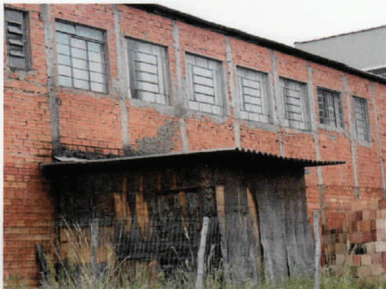
Foto 19 – Mostrando a parte dos fundos da construção comercial e seu nível de construção, acabamento e estado de conservação.
