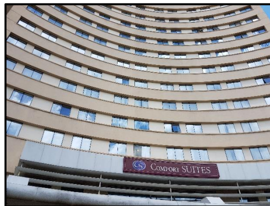
Detalhe da fachada
