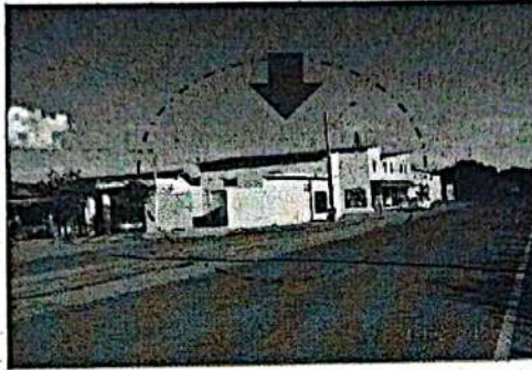
Foto nº01: Avenida 11 nº230, esquina com a Rua 1 (Estrada Municipal), Distrito de Ajapi, Município de Rio Claro- SP, Matrícula nº12.554 do 1º CRI da Cidade de Rio Claro SP, Contribuinte Municipal nº14.14.034.0011.001.
