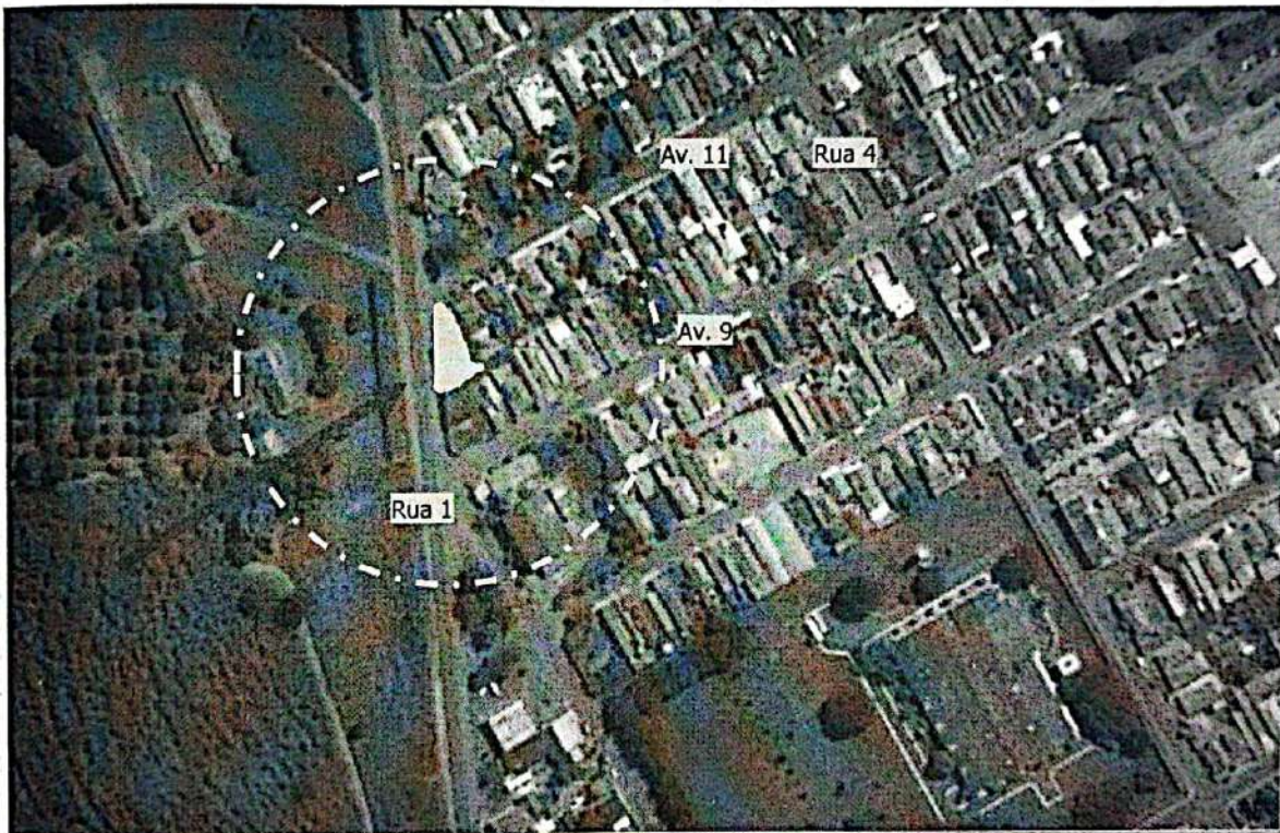
Foto nº03: Vista parcial aérea da região onde se localiza o imóvel avaliando, (situado no Distrito de Ajapi, Município de Rio Claro SP, atualmente o imóvel da Avenida 11 nº230, esquina com a Rua 1, (Estrada Rio Claro Ajapi), quadra completada pela Rua 4 e a Avenida 9, objeto da Matrícula nº12.554 do 1º CRI da Cidade de Rio Claro SP, Contribuinte Municipal nº14 14 034 0011 001).
