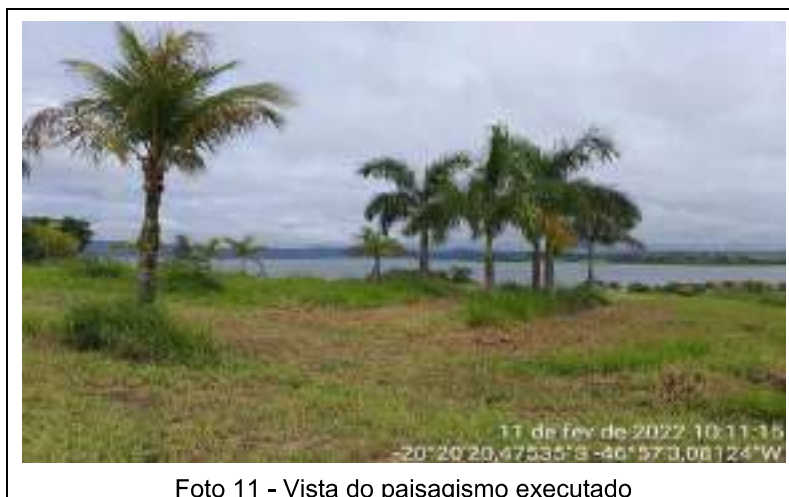
Foto 10 - Vista de lote com terraplanagem executada
