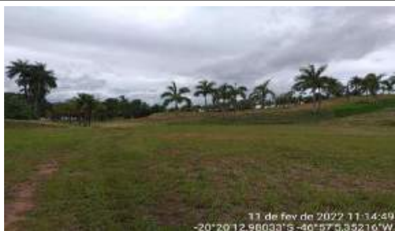
Foto 10 - Vista de lote com terraplanagem executada
