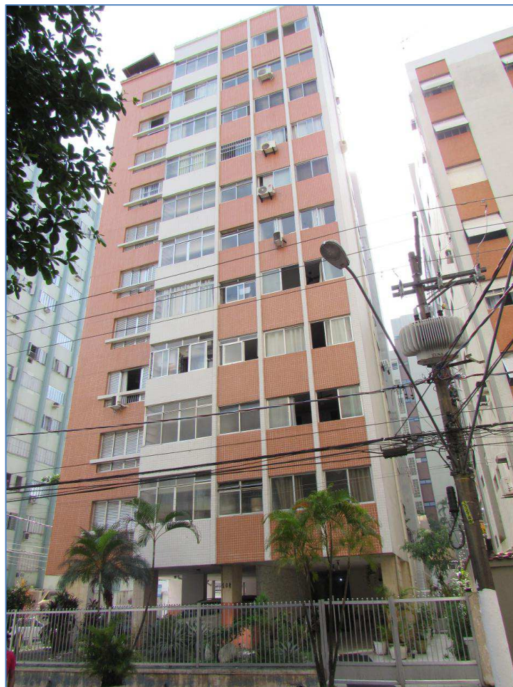
FACHADA DO EDIFÍCIO JOSÉ REBELLO.
