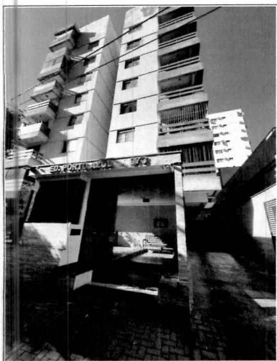
Foto 1: fachada do prédio
