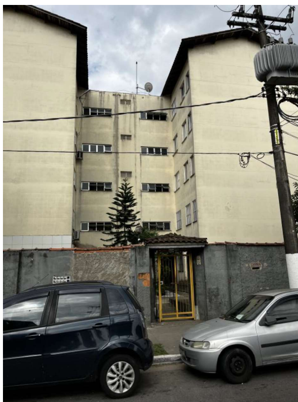
Figura 3: Vista geral do prédio.
