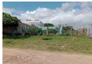
Representação Fachada Principal Descrição Data Foto 05/06/2023
