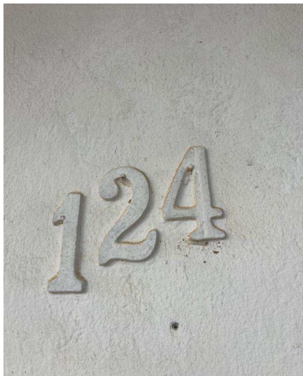
Representação Identificação Numérica Descrição Numeração Predial da Rua São Lourenço do Sul Data Foto 01/06/2023
