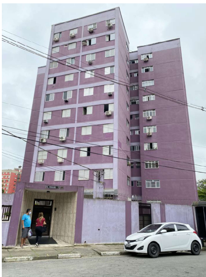
Figura 2: Vista geral do imóvel
