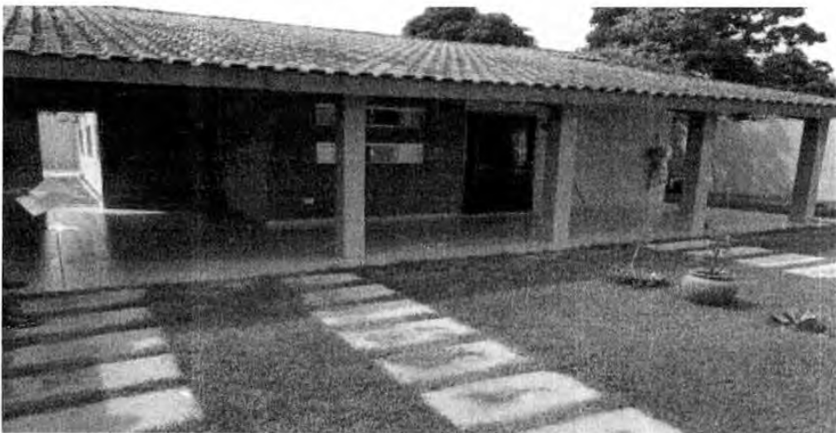
Figura 4. Varanda e garagem do imóvel
