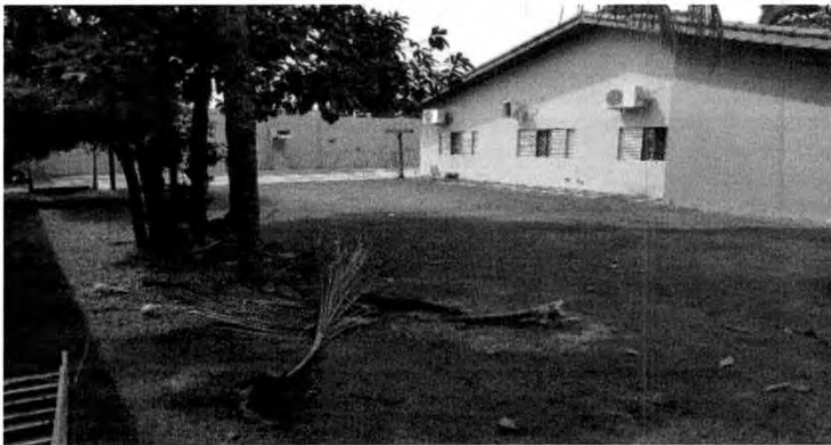
Figura 5. Quintal e parede lateral esquerda
