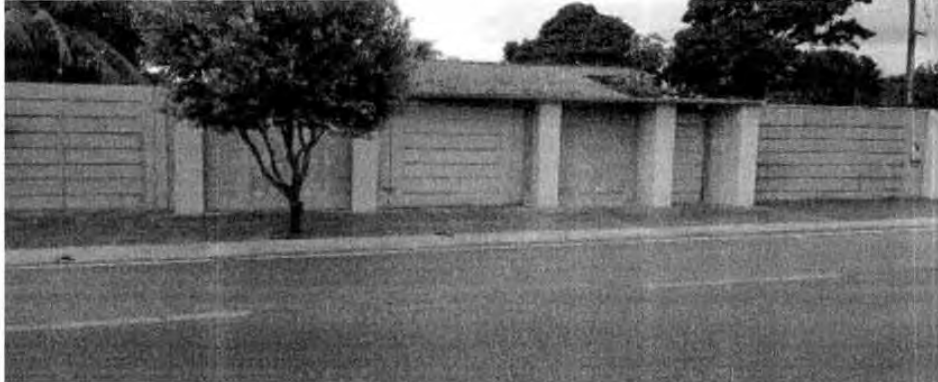
Figura 1. Frente do imóvel.
