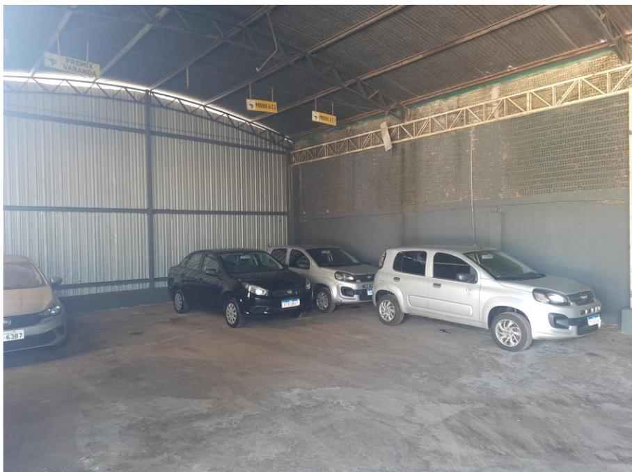
**Foto 16** - Vista interna do galpão, com cobertura de telha de fibrocimento apoiada em estrutura metálica
