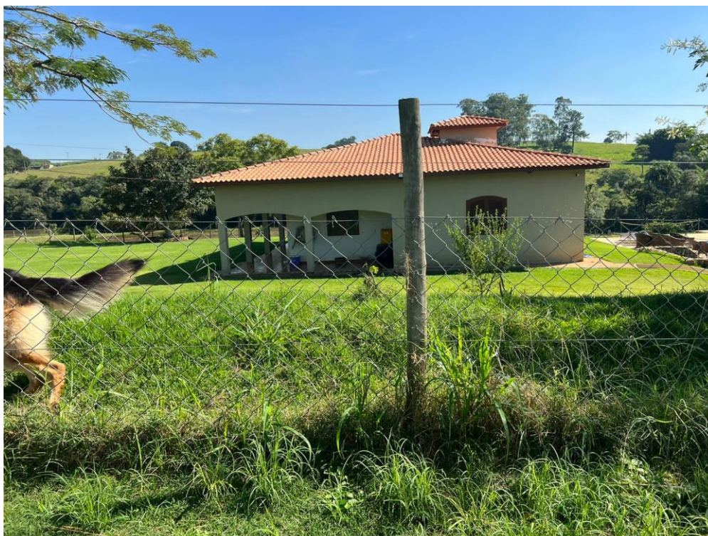
Foto 10 - Casa de alvenaria
