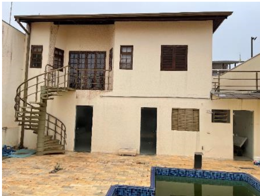
Foto 07. Edícula construída na divisa dos fundos
