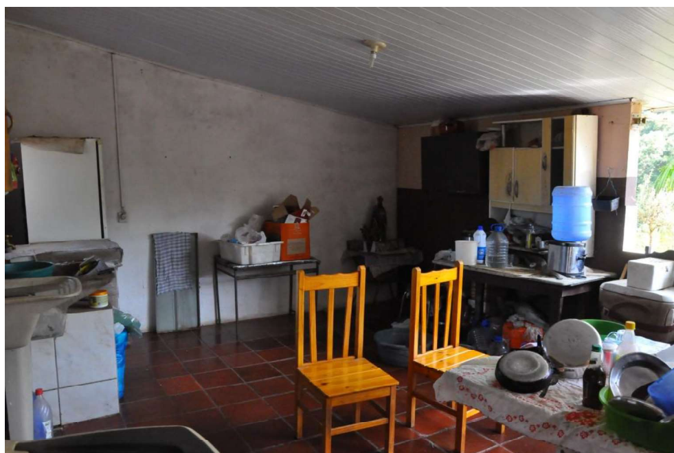
Figura 9 - Lavanderia do imóvel avaliando.
