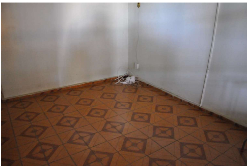
Figura 3 - Piso da sala do imóvel avaliando.
