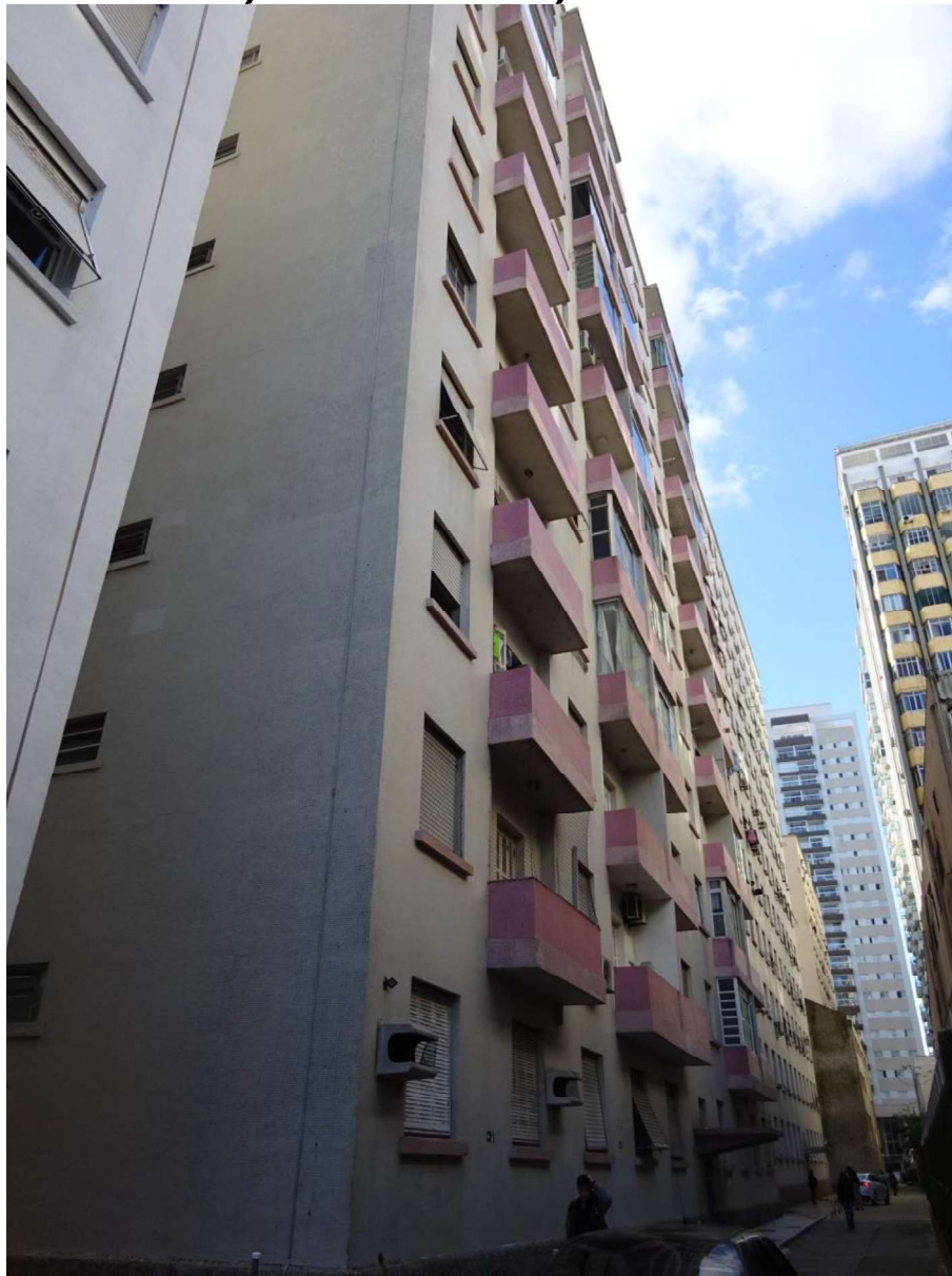
FOTO 2: Vista da fachada do Edifício Santana.
