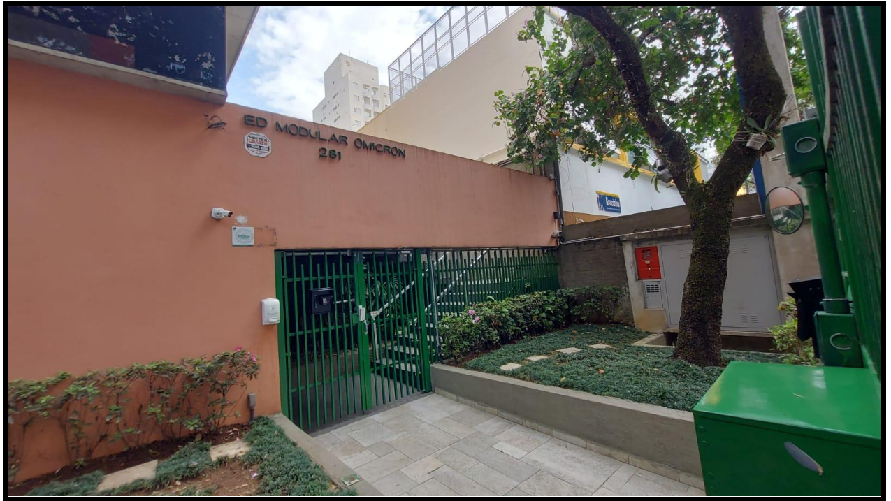
FOTO 02: FACHADA DO COND. OMICRON - Rua Tabapuã, 281
