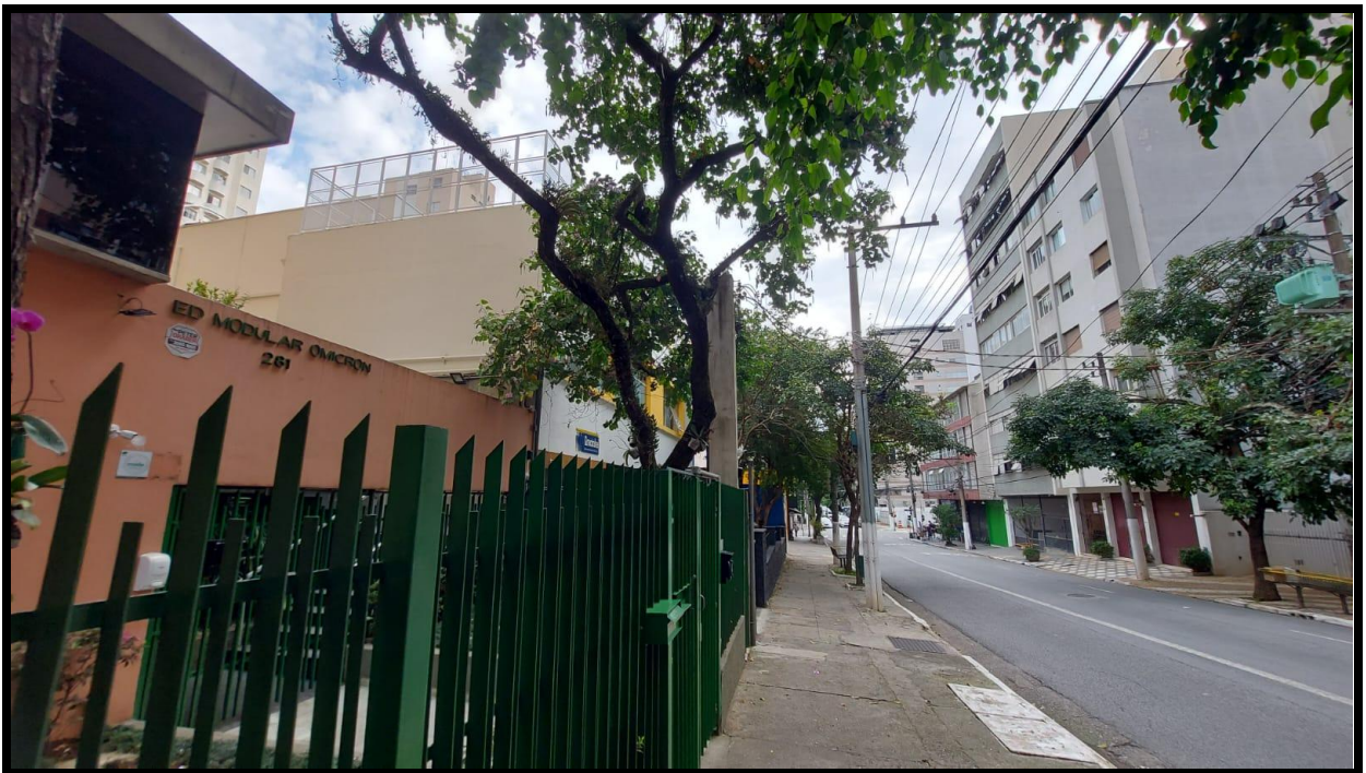
FOTO 05: FACHADA DO COND. OMICRON - Rua Tabapuã, 281
