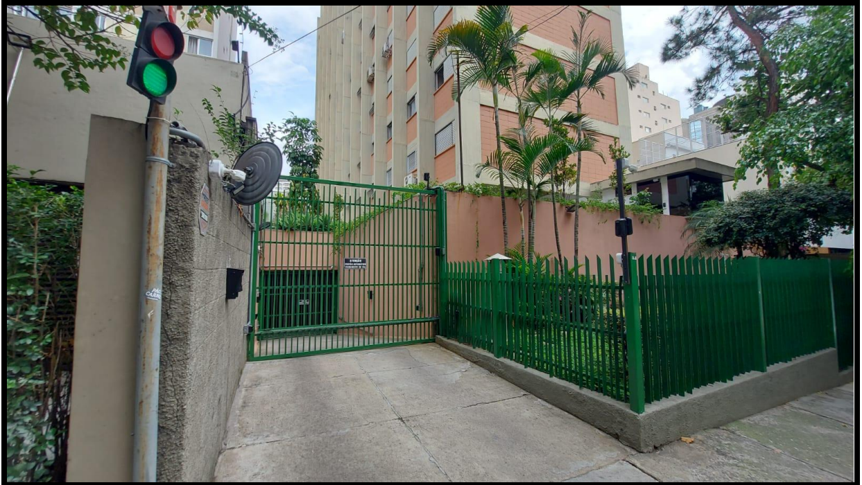
FOTO 04: FACHADA DO COND. OMICRON - Rua Tabapuã, 281
