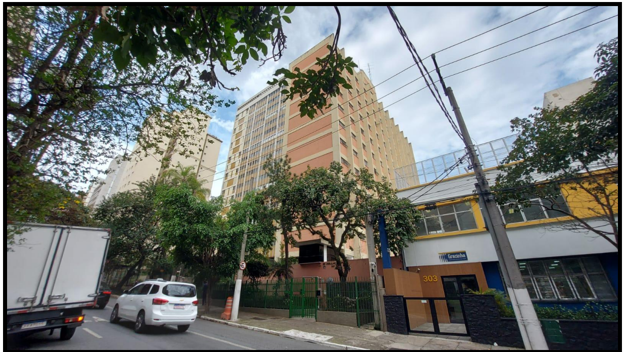
FOTO 03: FACHADA DO COND. OMICRON - Rua Tabapuã, 281
