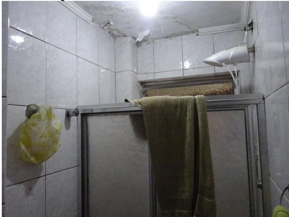
FOTO 6: Vista parcial do banheiro do imóvel avaliando.
