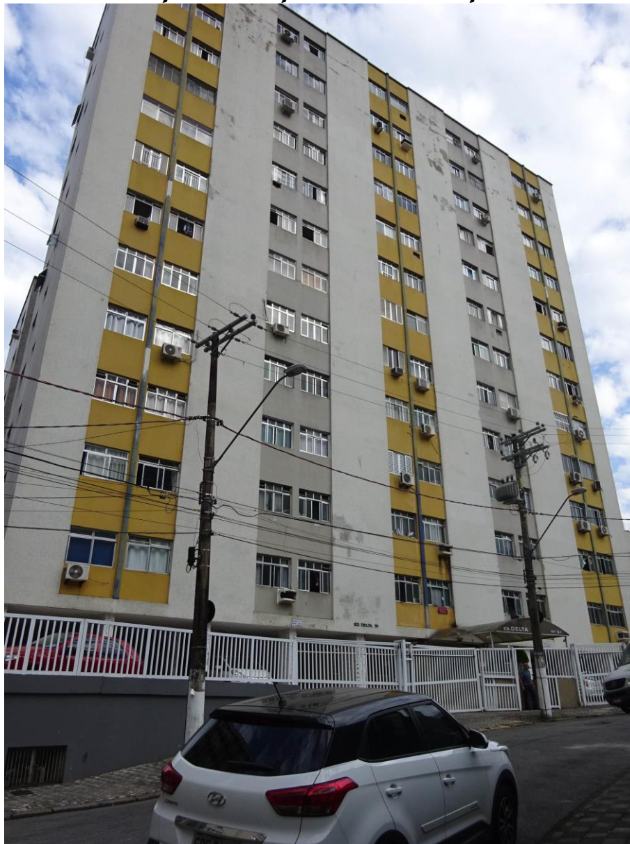
FOTO 1: Vista da fachada frontal do Edifício Bloco Delta.
