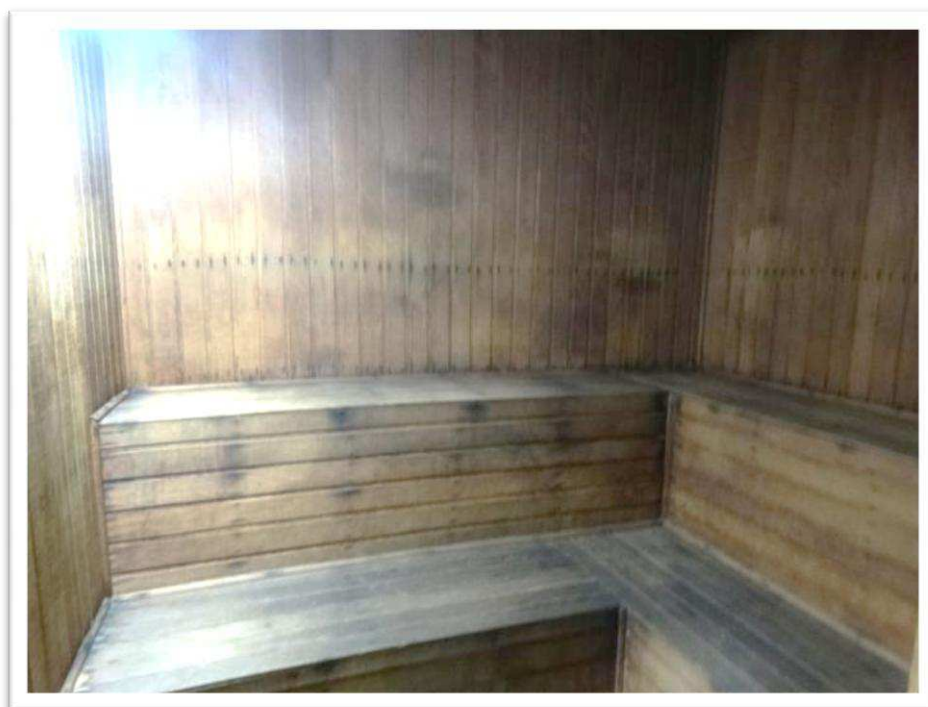
Foto nº 50 - Vista parcial do Condomínio Edifício Via Colomba – Sáuna.
