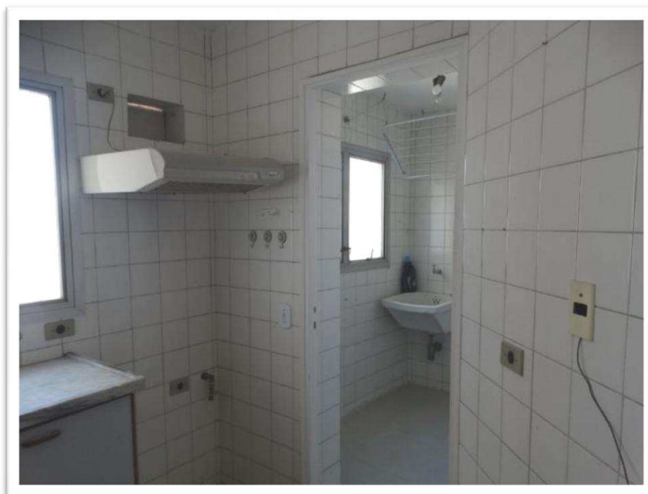
Foto nº 35 - Vista parcial interna do apartamento nº 111 do Edifício Via Colomba – Porta entre a Cozinha e a Área de Serviço.
