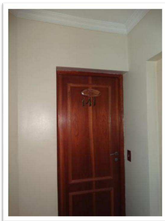
Foto nº 11 - Vista da porta de entrada do apartamento nº 141 do Edifício Via Colomba, objeto do presente laudo de avaliação.
