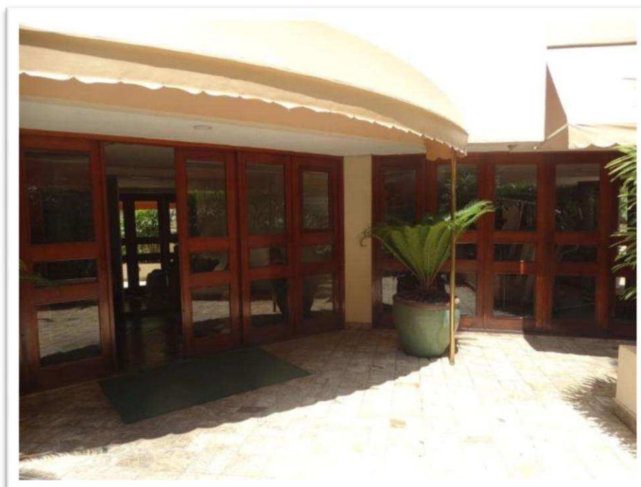
Foto nº 8 - Vista da porta de entrada social do Condomínio Edifício Via Colomba.
