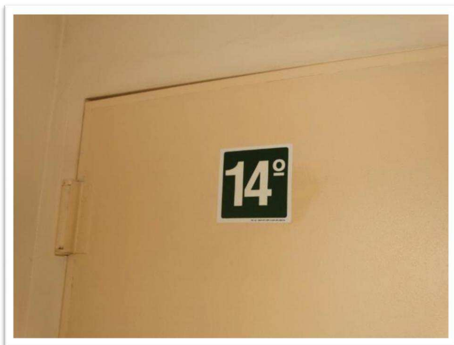
Foto nº 14 - Vista da identificação do andar, na caixa de escadas do Edifício Via Colomba.
