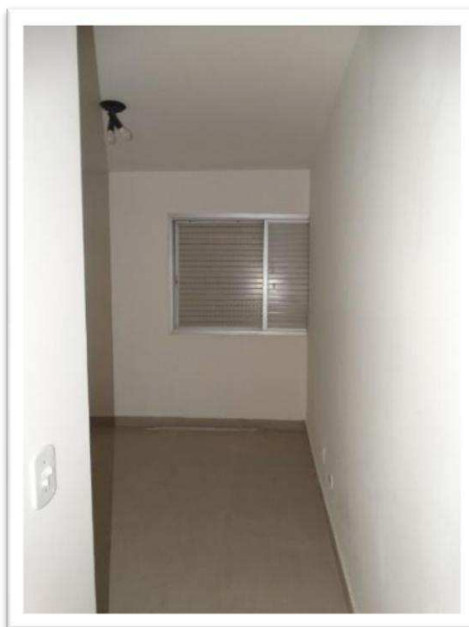
Foto nº 25 - Vista parcial interna do apartamento nº 111 do Edifício Via Colomba – Dormitório 1.
