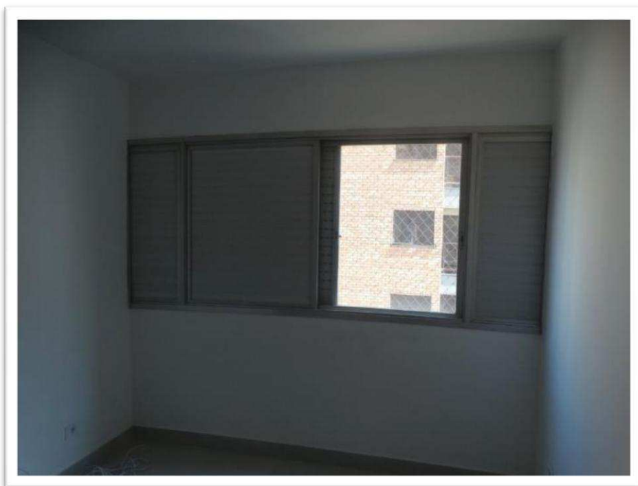
Foto nº 27 - Vista parcial interna do apartamento nº 111 do Edifício Via Colomba – Dormitório 2.
