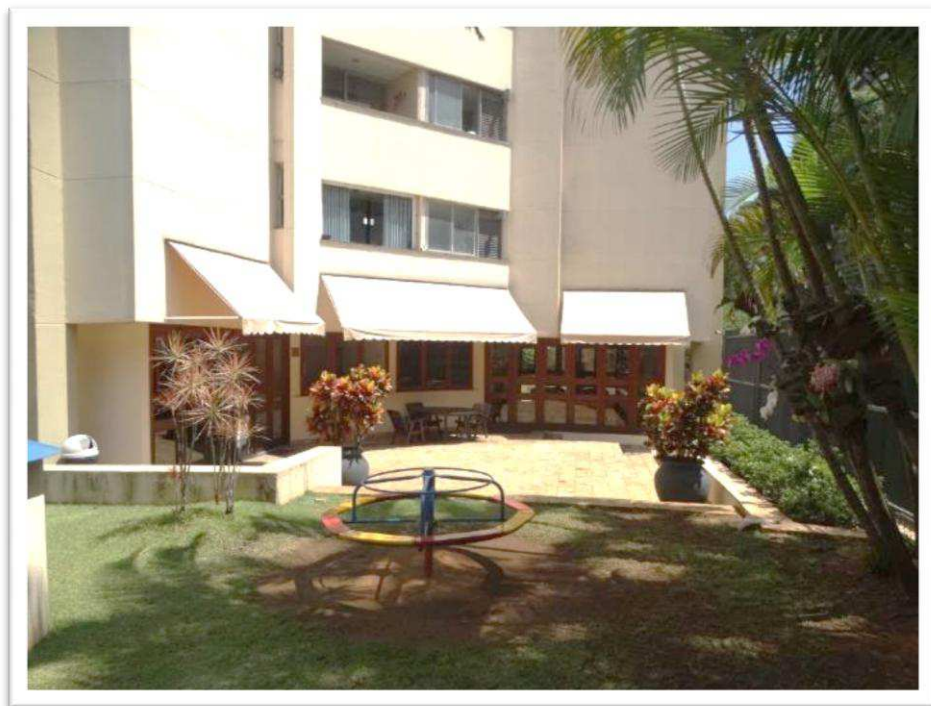
Foto nº 56 - Vista parcial do Condomínio Edifício Via Colomba – Playground.
