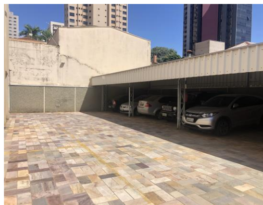
VISTA DA GARAGEM DO TÉRREO DO EDIFÍCIO
