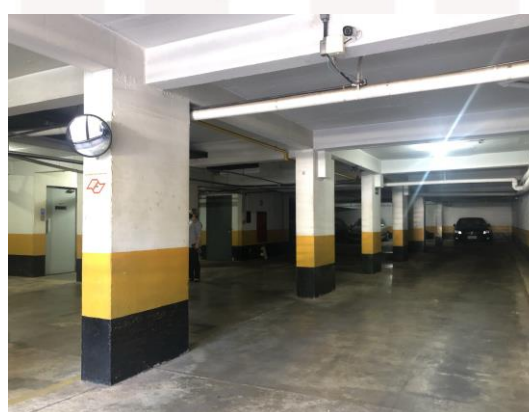
VISTA DA GARAGEM DO SUBSOLO DO EDIFÍCIO
