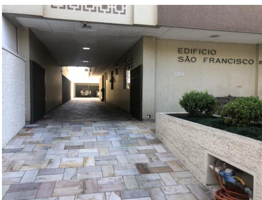
VISTA DA ENTRADA DA GARAGEM DO TERREO DO EDIFÍCIO
