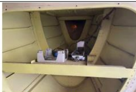
PT-HKK - RACK DE EQUIPAMENTOS TRASEIRO
