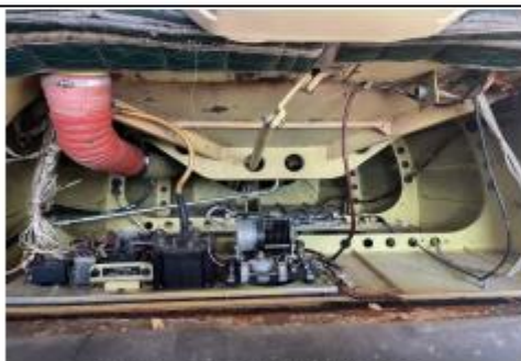
PT-HKK - COMPONENTES ELÉTRICOS
