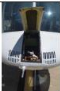
PT-HKL - COMPARTIMENTO DA BATERIA
